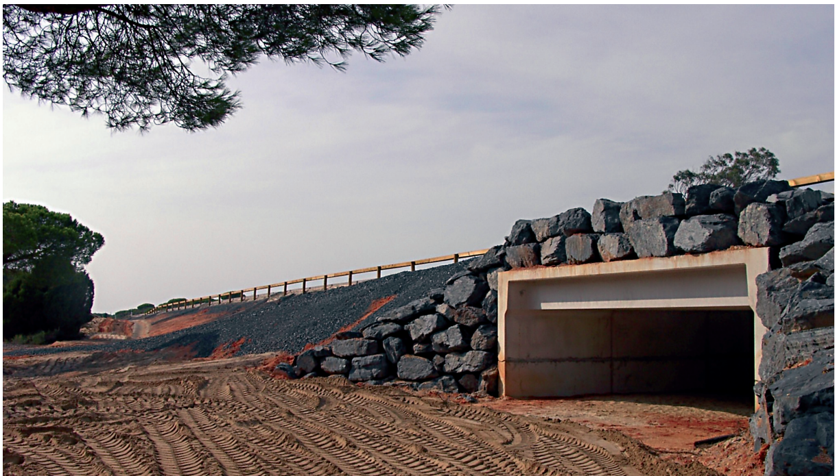
Figura 3.28. Ejemplo de paso inferior en el que se ha forzado el alzado para construir un paso para lince ibérico en una carretera en el entorno de Doñana. Foto: Minuartia.
