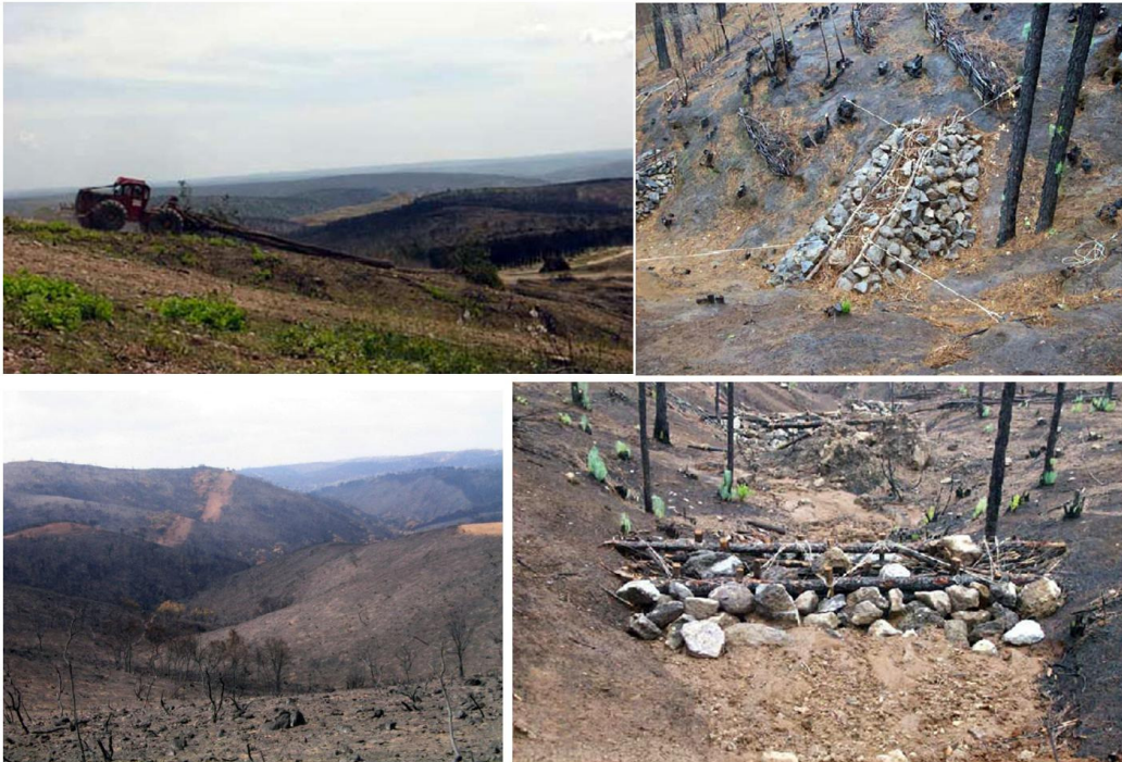
Restauración de áreas incendiadas.
