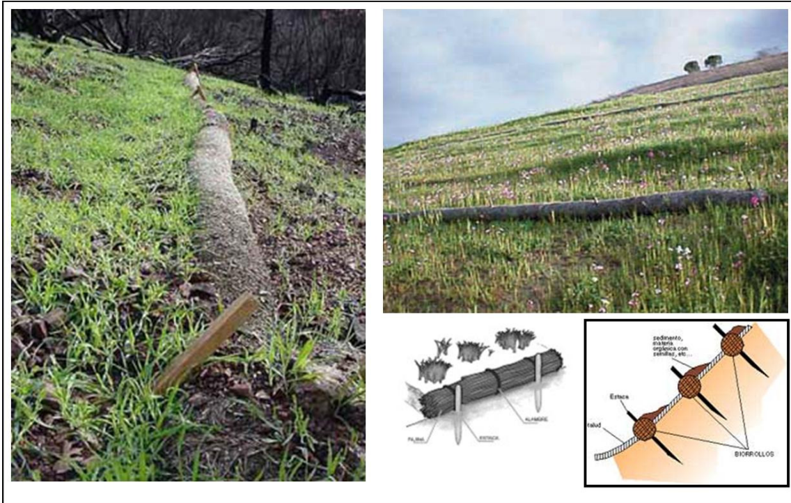
Utilización de fajnadas de material vivo (biorrollos).
