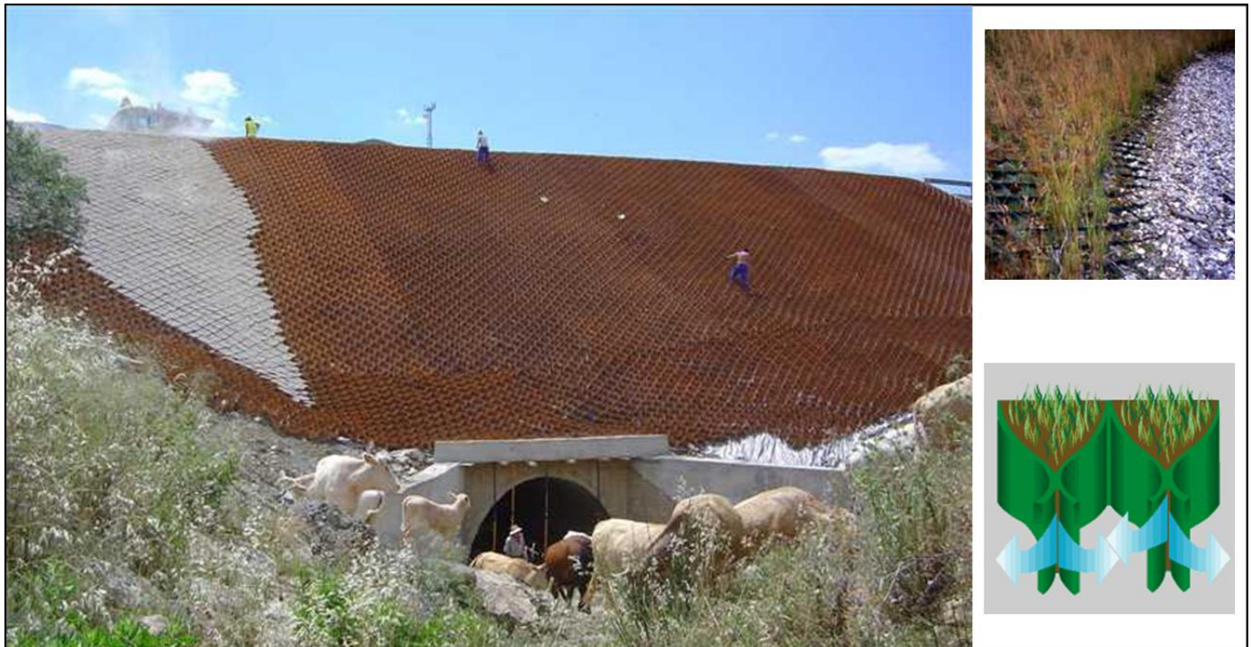
Geoceldas para control de la erosión.
