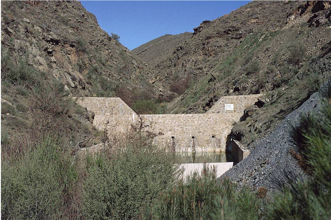
Los diques, obras transversales al eje del cauce, son la solución más simple y efectiva para la corrección de cauces torrenciales. Dique en un afluente del río Nacimiento, Almería. (Fuente: J. Nicolás)
