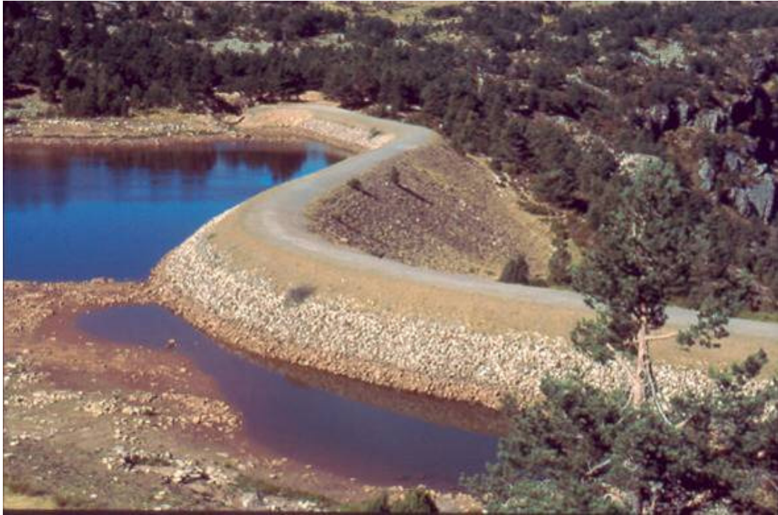
Obras transversales de corrección de cauces torrenciales: diques de tierra. (Fuente: J. Nicolás)
