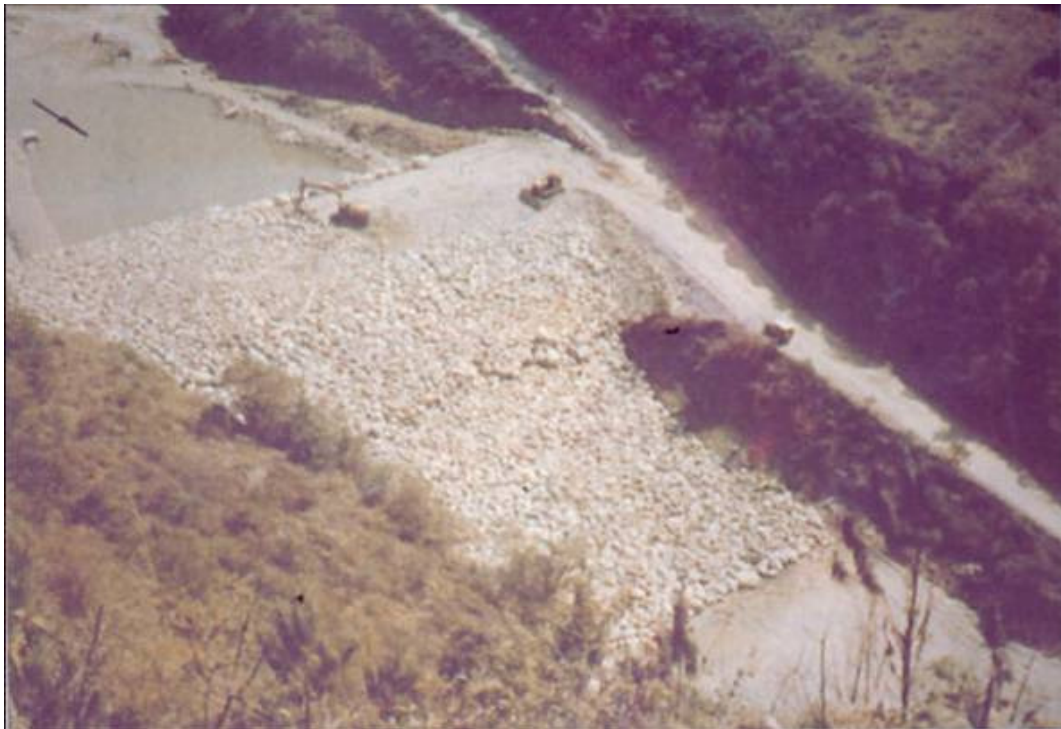
Obras transversales de corrección de cauces torrenciales: diques de tierra. (Fuente: J. Nicolás)
