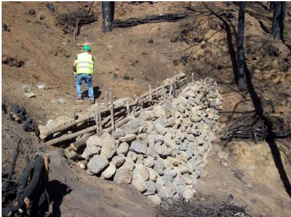
Dique mixto de mampostería y biomasa residual.
