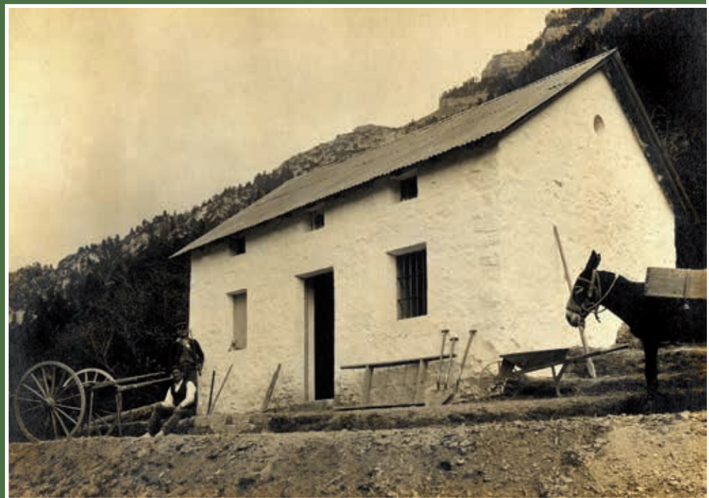
Cuartel de obreros y almacén en los trabajos de restauración en Arañones (Fuente: Archivo Histórico Provincial de Huesca AHPHU_A_00943_0013)
