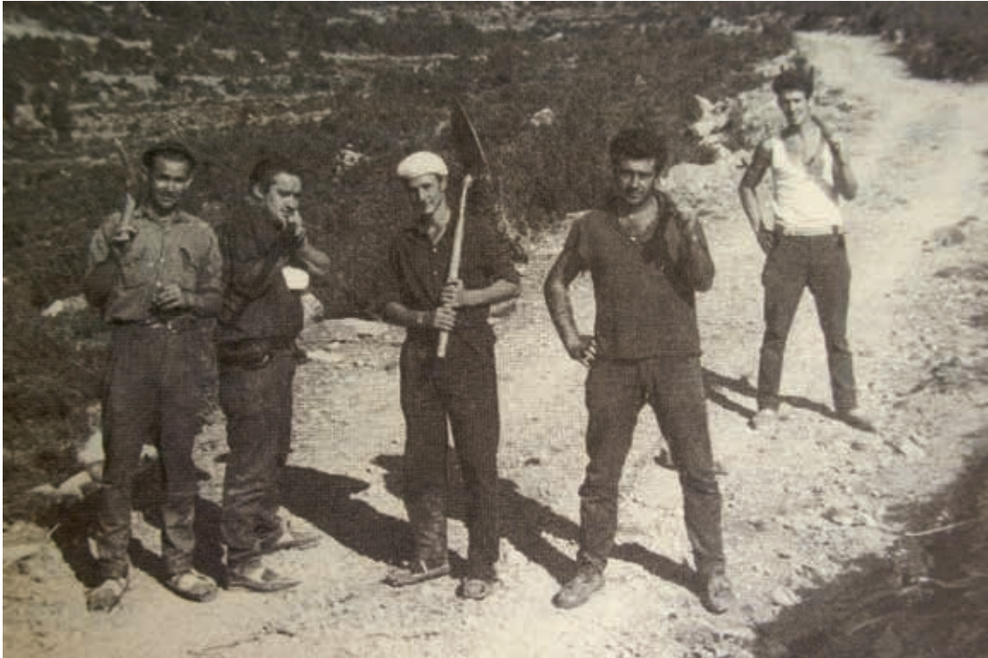
Figura 13 - Cuadrilla de obreros en la Solana de Burgasé en 1964 durante la apertura manual de una pista forestal.
