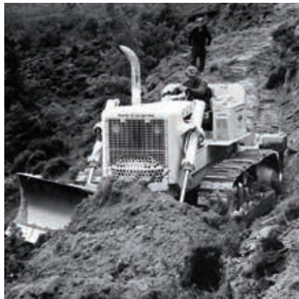
Figura 5 - Apertura mecanizada de terrazas con bulldozer (Fuente: Memoria del ICONA 1973).
