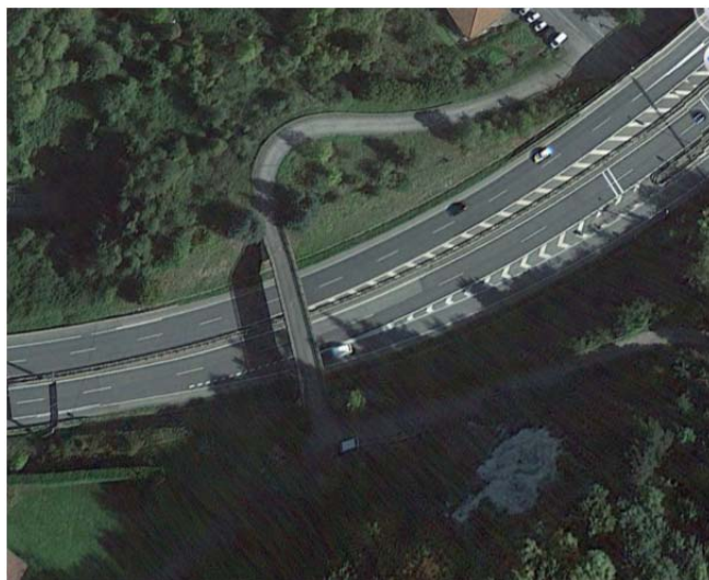
Figura 4.- Viales asfaltados que reponen carreteras, sin ninguna banda con sustrato natural.
