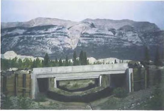
Figura 7.41 – En el Parque Nacional de Banff (Canadá) se construyeron dos viaductos, uno para cada una de las calzadas que constituyen la autopista Transcanadiense, con el fin de reducir al mínimo la longitud de las zonas situadas bajo el viaducto y para facilitar la entrada de luz bajo las estructuras. (Foto de H. Bekker)
