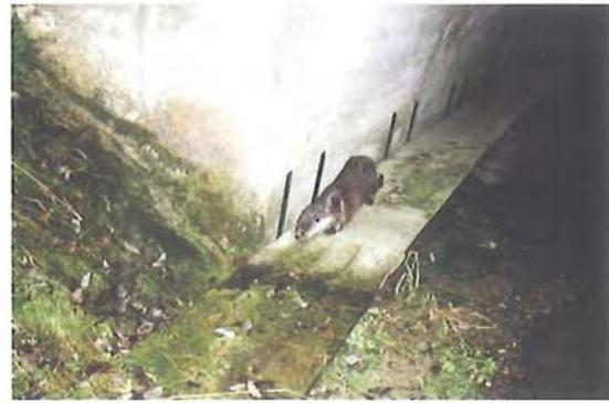
Figura 7.62 – Una plataforma de madera colocada en el interior de un drenaje que está siendo regularmente utilizada por nutrias en la República Checa. (Foto de V. Hlavác)
