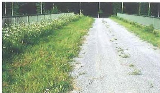
Figura 7.32 – Una franja con vegetación a ambos lados de la pista forestal facilita el paso de fauna a través de este puente situado sobre una línea de ferrocarril de alta velocidad cerca de Oberderdingen, en Alemania. (Foto de B. Georgii)
