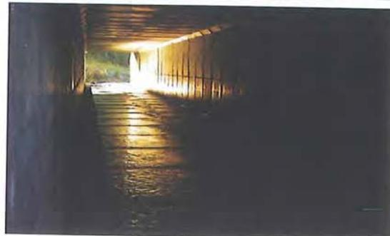
Figura 7.67 -Chapas divisorias en un canal a su paso por el interior de un drenaje en Noruega, durante y después de la construcción. (Fotos de B. Iuell)
