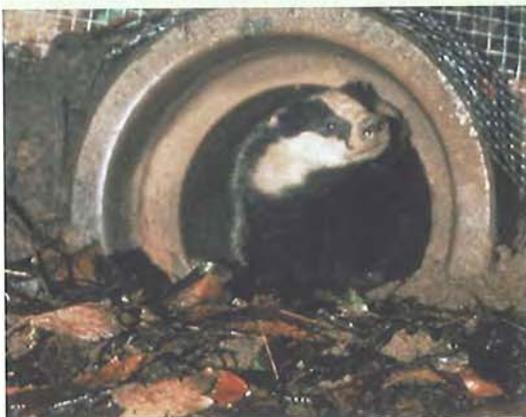
Figura 7.56 – Un pequeño paso inferior de fauna en Holanda, utilizado por un tejón. Esta estructura también puede ser útil para otros mustélidos, micromamíferos y anfibios. El diámetro de los pasos para tejones construidos en este país oscila entre 0,3 y 0,6 m, y su longitud entre 5 y 60 m. (Foto de Vereniging 'Das en Boom')
