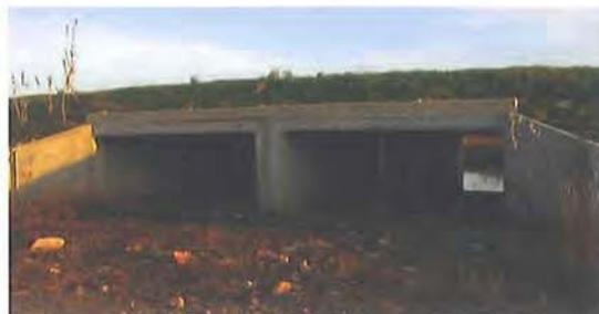
Figura 7.46 – Este paso inferior situado en una carretera que cruza un humedal protegido en Cataluña (Parque Natural de Aiguamolls de l'Empordà) fue construido con tabiques para reducir costos. Las dimensiones son: 10 m de ancho (5 m cada sección), 2 m alto, 28 m largo. Lo utilizan diversas especies de mamíferos como la nutria, el turón, el tejón y el jabalí, y también algunas aves del humedal adyacente. (Foto de C. Rosell)
