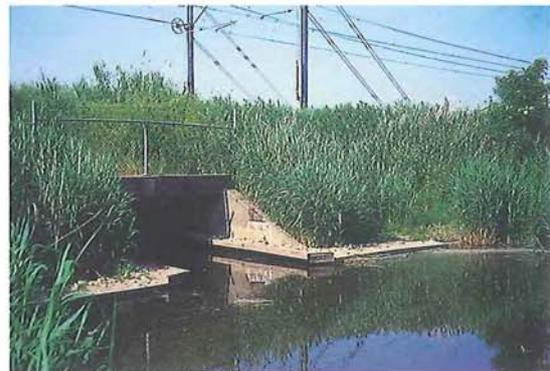
Figura 7.63 – Un drenaje adaptado bajo una vía férrea en Holanda. Las plataformas laterales se han construido con una buena conexión con los taludes del terreno adyacente. Estas plataformas, que pueden ser de madera u hormigón, deben tener una anchura superior a 0,7m y su diseño debe ser tan abierto como sea posible. (Foto de H. Bekker)
