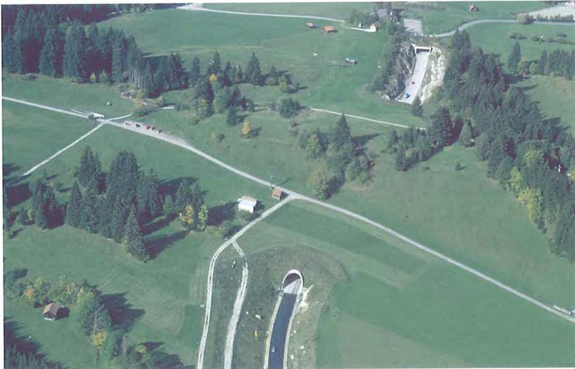
Figure 6.9 - Los túneles perforados dejan el hábitat de la superficie intacto. Son soluciones idóneas en zonas montañosas, como este ejemplo en Bavaria, Alemania. (Foto de B. Georgii)
