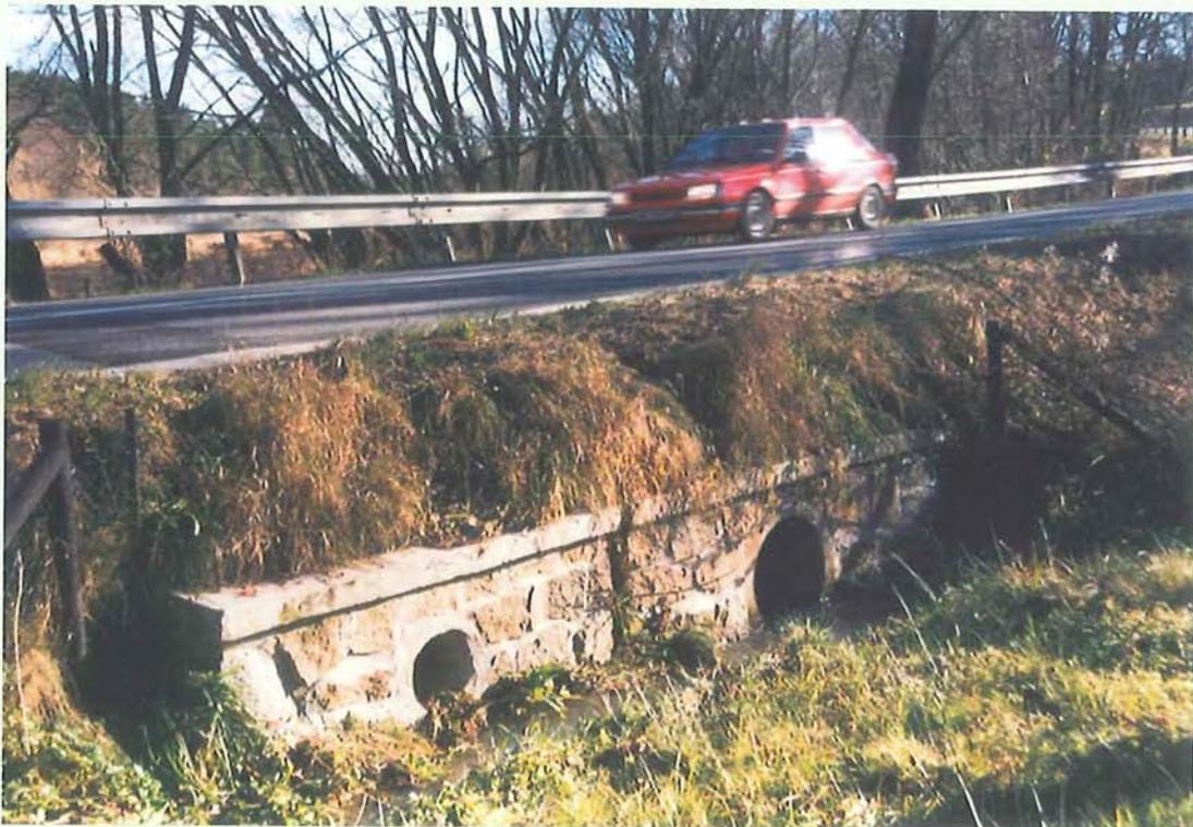
Figura 7.58 – Las nutrias no utilizan pasos completamente inundados. Si usan, en cambio, pequeños tubos paralelos a los drenajes pero situados por encima del nivel del agua, como estos que cruzan por debajo de una carretera del sureste de la República Checa. (Foto de V. Hlaváč)
