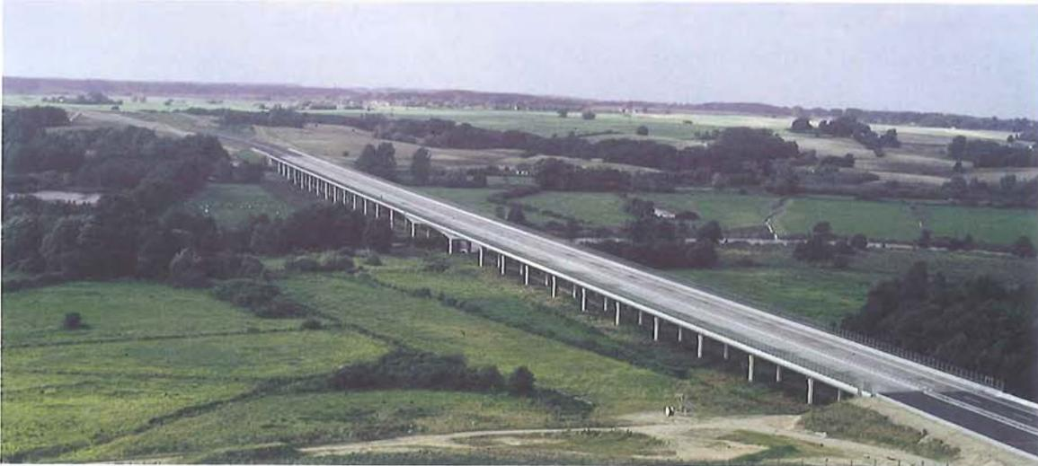
Figura 7.36 – Como alternativa a la construcción de un terraplén, la plataforma de la autovía A20 en el noreste de Alemania, se situó sobre un viaducto que permite conservar los hábitats asociados al río y las llanuras inundadas de sus alrededores. (Foto de DEGES)
