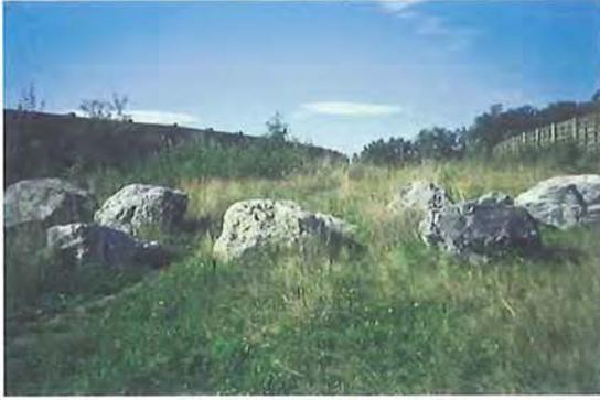
Figura 7.28 – Rocas colocadas en el acceso de un paso superior en la autopista 64 en Francia para impedir el paso de vehículos. (Foto de H. Bekker)
