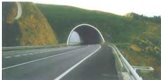
Figura 7.30 – Un falso túnel acondicionado para facilitar su uso por parte de la fauna. (Foto de C. Rosell)
