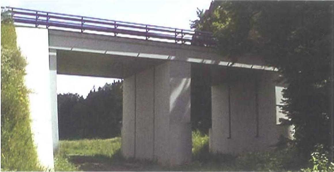
Figura 7.50 – Un paso inferior situado bajo una vía férrea en la República Checa. El paso de fauna se ha combinado con una pista agrícola sin pavimentar y sus grandes dimensiones permiten que también sea adecuada para grandes mamíferos. (Foto de J. Dufek)
