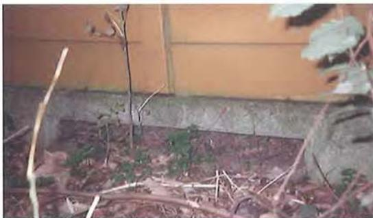
Figura 7.88 – Esta pantalla acústica tiene aberturas en la parte inferior para reducir el efecto barrera para los animales más pequeños. (Foto de H. Bekker)
