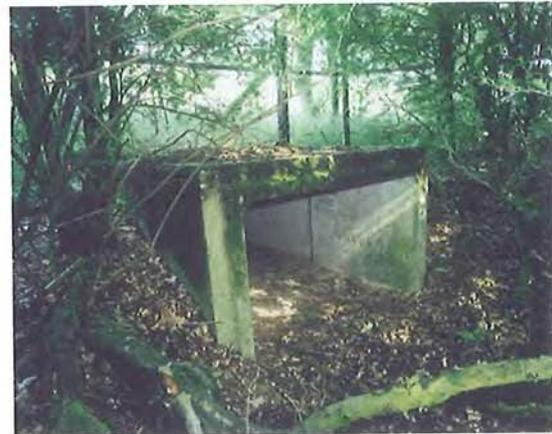
Figura 7.53 – Un paso inferior rectangular para animales pequeños (1,2 m de ancho, 0,8 m de alto y 40 m de largo) situado en la autopista A50 cerca de Hernen, Países Bajos. Este paso inferior lo utilizan con frecuencia los tejones. (Foto de H. Cormont)
