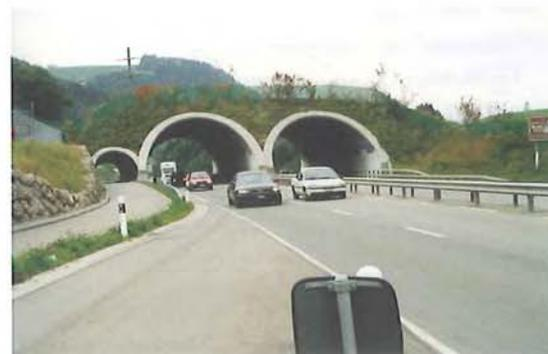
Figura 7.24 – Esta foto muestra el mismo paso elevado de Schindellegi que se muestra en la figura 7.22 una vez finalizada su construcción. La pendiente en los accesos es muy pronunciada; no obstante, los ciervos y otros animales lo usan con frecuencia, probablemente porque está situado en una zona montañosa. (Foto de V. Hlaváč)
