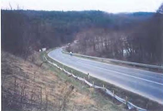
Figura 7.70 – Para interceptar el desplazamiento de los anfibios se puede instalar una lámina de plástico opaco y resistente, como en este ejemplo en Hungría. Sin embargo, los postes no deben colocarse como se ha hecho en este caso, en la parte por la que se acercan los anfibios, para no interferir la función de la valla de conducir a los animales hacia los cubos de recolección o a los posibles pasos. (Foto de M. Puky)
