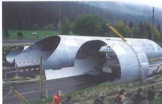
Figura 7.22 – Para el paso superior de Schindellegi en Suiza, de 40 m de ancho, se utilizaron componentes de acero corrugado. La estructura se construyó durante las obras de ampliación de la carretera, permitiendo el flujo del tráfico por un carril durante toda la fase de construcción. (Foto de O. Holzgang)
