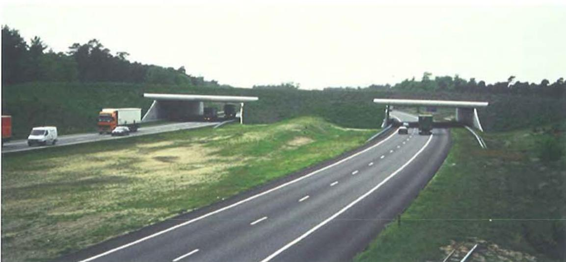
Figura 7.18 – El paso superior de fauna Harm van der Veen (Kootwijk, Países Bajos) se construyó en 1998 cubriendo dos partes separadas de la autopista A1. Fue un acontecimiento importante, porque supuso el primer paso elevado que se construyó en los Países Bajos sobre una autopista ya construida. (Foto de H. Bekker)
