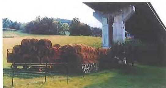
Figura 7.40 - En este ejemplo de la RN59 en Francia, la función del viaducto era procurar que los animales se pudieran desplazar libremente. No obstante, un uso inadecuado ha comportado que el acceso esté bloqueado por una valla y material almacenado. (Foto de J. Carsignol).
