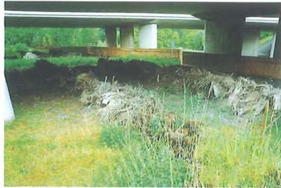
Figura 7.42 – Estas hileras constituidas por troncos de árboles se utilizaron para proporcionar refugio para los animales bajo el viaducto de Zandheuvel en la A27 en los Países Bajos. Al fondo se observa una pantalla de madera que separa la zona de paso de fauna de una carretera local. (Foto de H. Bekker)
