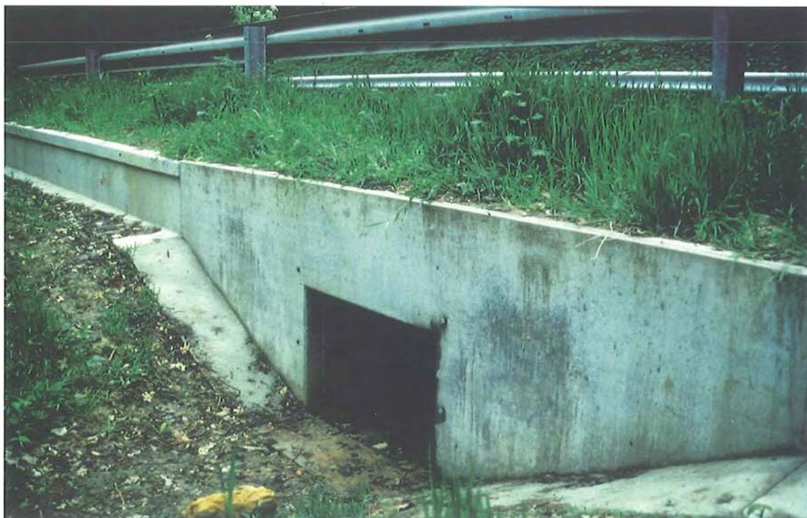
Figura 7.72 – Vista de un paso rectangular en Alemania con estructuras de guía bien delimitadas. (Foto de J. Niederstrasser)
