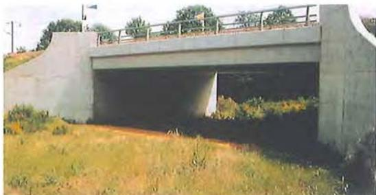
Figura 7.45 – El índice de apertura de este paso inferior situado bajo de una línea de alta velocidad, en Francia, es adecuado para facilitar el paso de grandes mamíferos. (Foto de SETRA)
