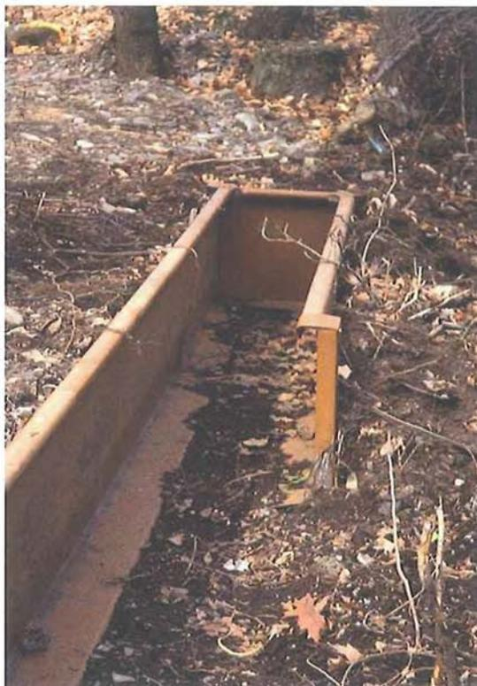
Figura 7.71 – La forma en U al final de la valla obliga a los animales a retornar al hábitat del que provienen y se reduce el número de los que entran en la carretera aprovechando este punto. (Foto de S. Zumbach)
