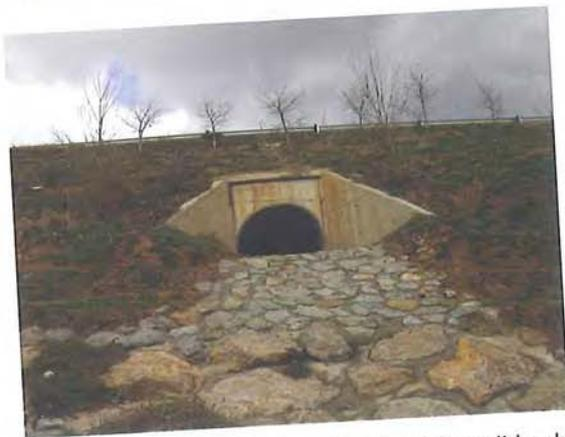
Figura 7.64 – Los bajantes escalonados de las salidas de los drenajes se pueden convertir en trampas para los animales pequeños (foto superior). Estos bajantes pueden adaptarse para el paso de fauna abriendo las paredes laterales (centro) o mediante construcción de enmacados de piedra (abajo) permitiendo que los animales que usan el drenaje puedan acceder a los taludes con facilidad. (Fotos de C. Rosell)
