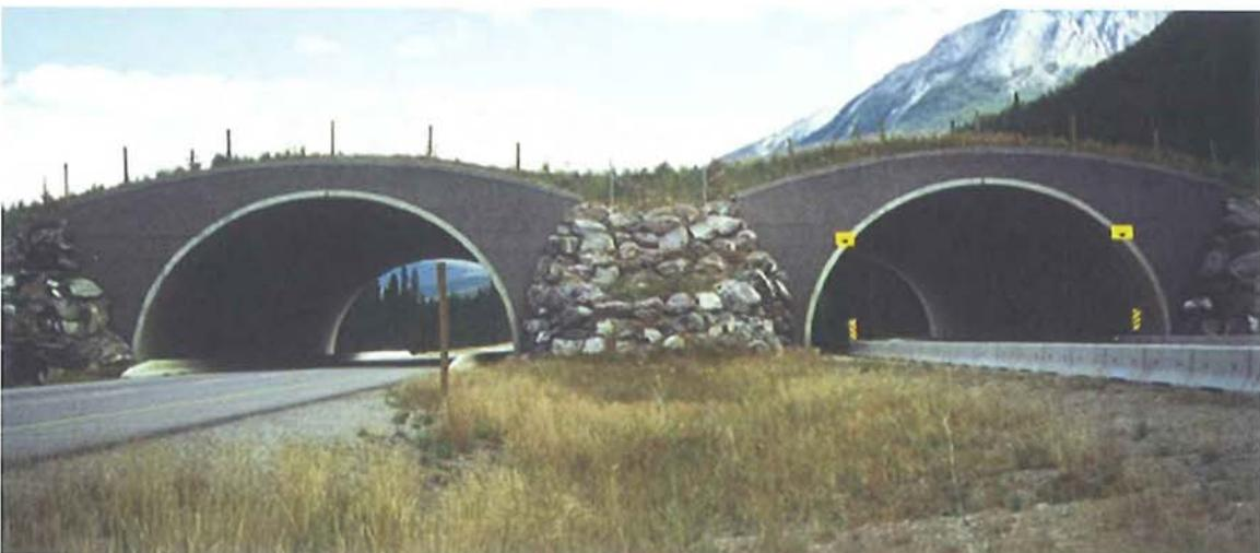
Figura 7.19 – Este paso superior de fauna en el parque nacional de Banff en la autopista Transcanadiense se construyó con componentes prefabricados sobre una carretera ya construida. (Foto de H. Bekker)
