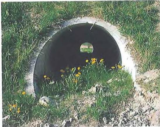
Figura 7.52 – Un tubo diseñado como paso de pequeños animales en la autopista B31neu en Alemania. La base se ha rellenado con tierra, aunque su reducido diámetro (1 m) dificultó la operación. (Foto de V. Keller)
