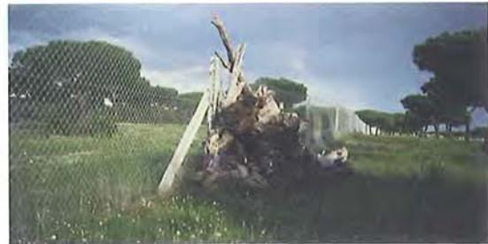
Figura 7.79 – Una salida sencilla construida con tocones de árboles para permitir al lince ibérico el retorno al exterior de la vía en caso de quedar atrapado en un tramo con vallado perimetral. Entorno de Doñana, Andalucía. (Foto de H. Bekker)
