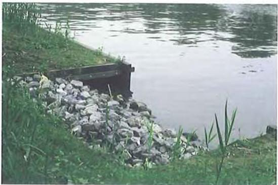
Figura 7.94 – Diferentes posibilidades de sistemas de salida para la fauna en canales en Holanda. El acondicionamiento de este tipo de rampas solo es posible cuando no supongan un riesgo para las embarcaciones. Las pueden utilizar una amplia diversidad de especies como tejones, corzos y patos. (Fotos de H. Bekker)
