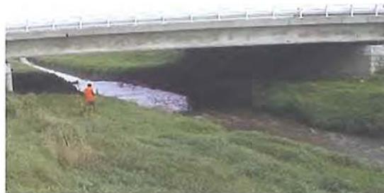
Figura 7.48 – Si los puentes situados sobre los arroyos tienen una anchura suficiente para conservar los márgenes naturales del río, los animales los pueden utilizar como pasos inferiores, como en este ejemplo en la República Checa. (Foto de J. Dufek)
