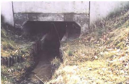
Figura 7.61 – Una drenaje de 2,5 m de diámetro, construido en acero corrugado, en la carretera C25 en Cataluña, por el que sólo discurre agua durante períodos de fuertes lluvias. El recubrimiento de la base con hormigón facilita el paso de diversas especies de pequeños y medianos mamíferos como conejos, zorros, etc. (Foto de C. Rosell)
