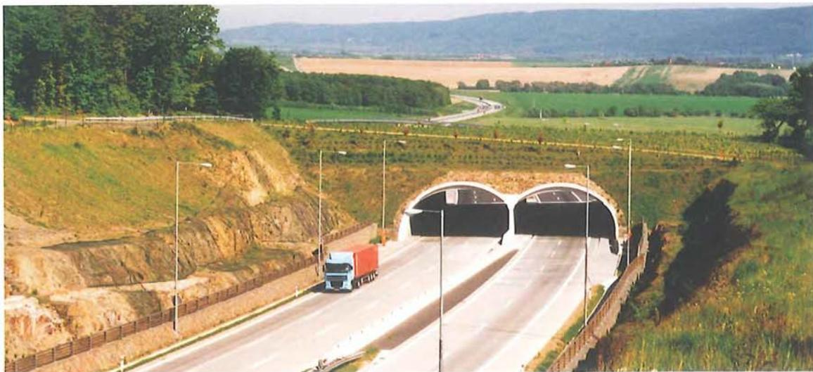
Figura 4.4 – El efecto barrera de la infraestructura se puede reducir aplicando medidas correctoras. Este es un paso superior cerca de Lipník nad Bečvou, República Checa, frecuentemente utilizado por muchas especies, incluido el corzo y el oso. (Foto de V. Hlaváč)
