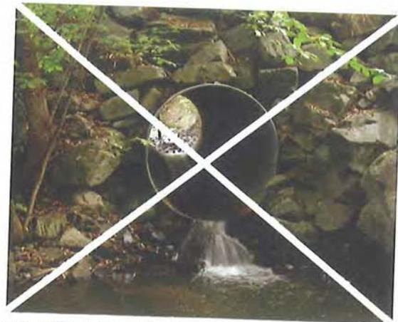
Figura 7.66 – Este drenaje en Noruega, tiene su salida a un nivel demasiado alto en relación al curso fluvial. El desnivel supone una barrera para los peces que se dirigen aguas arriba (Foto de B. Iuell)
