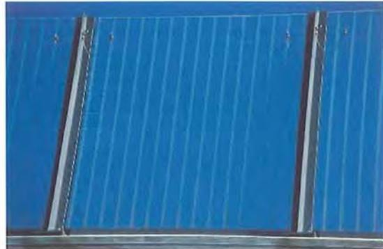
Figura 7.89 – Pantalla acústica transparente en una autovía de Suiza con marcas verticales. (Foto de H. Schmid)
