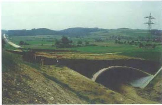
Figura 7.20 – La forma del ecoducto de 80 m situado en el espacio natural de Hirschweg (B31neu, sureste de Alemania) aprovecha el desnivel de la montaña y dirige a los animales hacia el paso, que se ha colocado en un tramo en el que la vía discurre entre desmontes. La fotografía se tomó antes de la plantación de los arbustos que constituyen la pantalla de protección. El ecoducto empezó a ser intensamente utilizado por mamíferos en cuanto se cubrió con tierra. (Foto de V. Keller)
