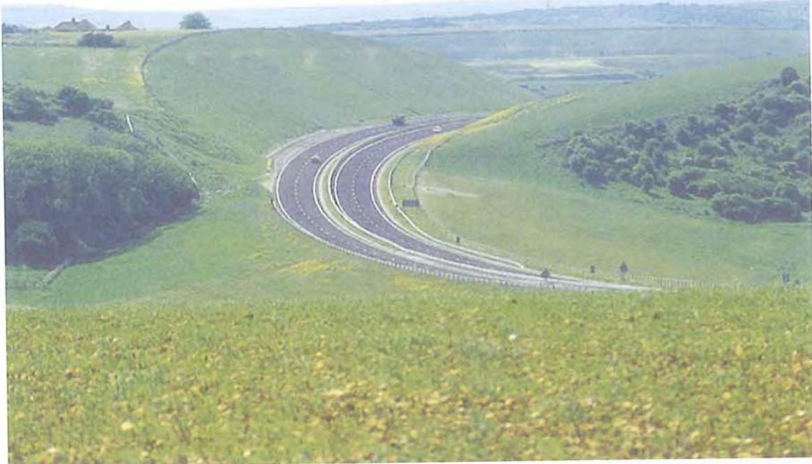
Figure 6.2 - La carretera de circunvalación A27 de Brighton bordea la zona de South Downs en el Sureste de Inglaterra, designada como Lugar Natural de Belleza Destacada (AONB). Nivelando los desmontes y terraplenes en una proporción de 1:6 se ha conseguido dar a la carretera un carácter similar a su entorno. (Foto de Highways Agency, RU)
