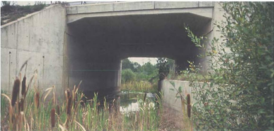
Figura 7.51 – El principal objetivo de este paso inferior en la autopista A10 en Francia, es el drenaje de aguas de un humedal próximo. La instalación de una banqueta lateral que se mantiene seca permite que también sea utilizado para el paso de mamíferos de tamaño pequeño y mediano. (Foto de H. Bekker)
