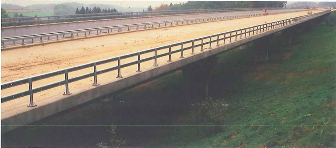
Figura 7.37 – Un largo viaducto situado en una zona de media ladera, permite el libre desplazamiento de animales, como en este ejemplo, en una autovía de Suiza. (Foto de H. Bekker)
