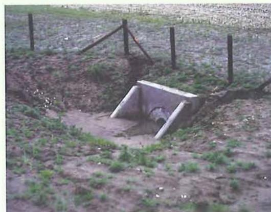
Figura 7.57 – Este paso, construido en Holanda, ha quedado parcialmente inundado y colmatado con arena. La lección aprendida de este ejemplo es que los pasos deben estar construidos por encima del nivel del acuífero y que sus accesos deben tener pendientes estables, que no puedan resultar afectadas por la erosión. (Foto de H. Bekker)
