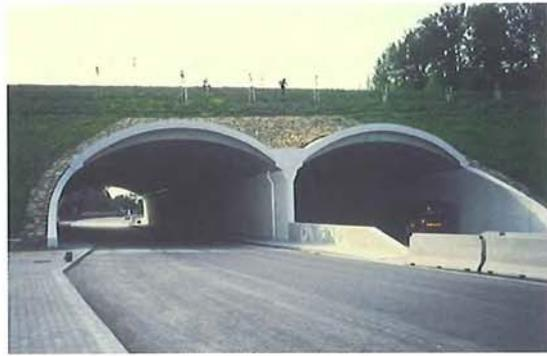
Figura 7.21 – Paso superior de fauna en la República Checa construido con dos bóvedas prefabricadas de hormigón. (Foto de H. Bekker)
