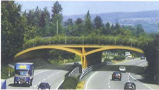
Figura 7.26 – Hasta ahora, raramente se ha utilizado la madera para la construcción de pasos superiores. Este fotomontaje de un proyecto suizo muestra el aspecto que podría tener una moderna construcción de un paso superior de madera. (Ilustración de Marbach & Marbach, Eich, Copyright Swiss Ornithological Institute)
