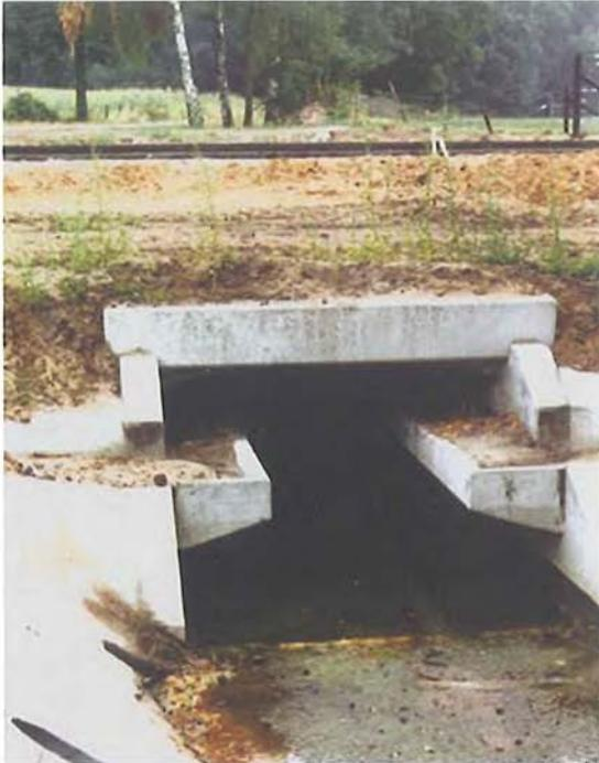
Figura 7.60 – Dos drenajes prefabricados situados en las autopistas A35 y A1 en Holanda, con plataformas laterales integradas que son utilizadas para el paso de pequeños animales. (Fotos de G. Veenbaas y H. Bekker)
