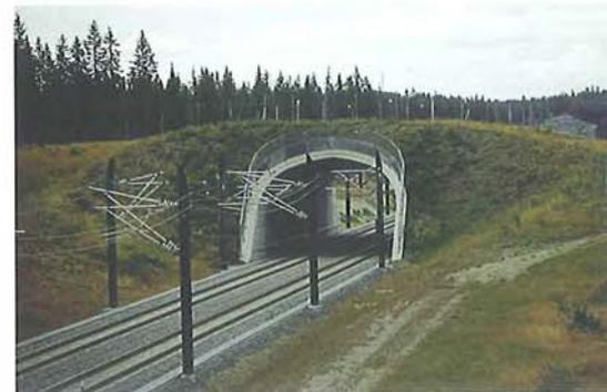
Figura 7.25 – Paso superior de fauna, de 44 m de ancho, que cruza una línea férrea de alta velocidad en Noruega y permite mantener una importante ruta de migración de alces. (Foto de L. Kastdalen)
