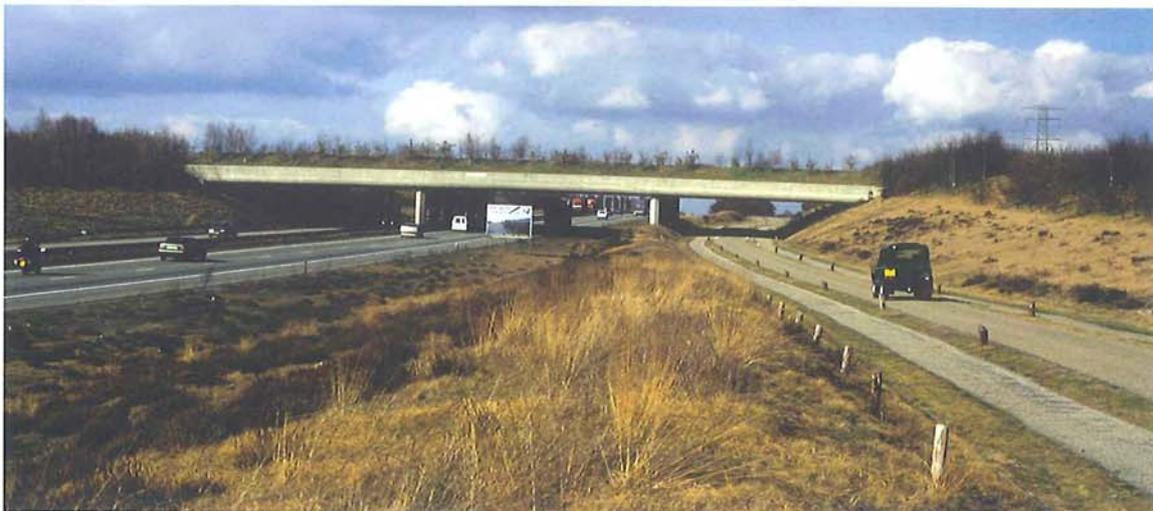
Figura 7.17 – La vista lateral del ecoducto Terlet al norte de Arnhem (Países Bajos) muestra una construcción de hormigón recta sobre pilares. La rasante de la carretera se ha bajado para que los accesos del paso estén situados al nivel del terreno adyacente. (Foto de V. Keller)
