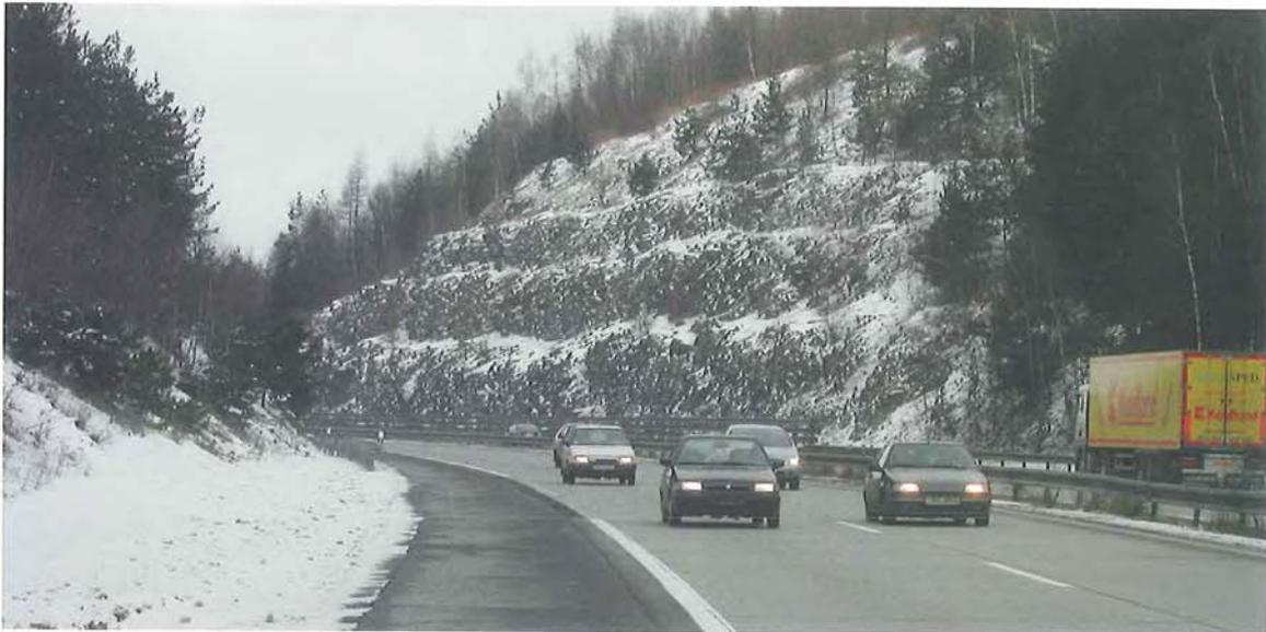
Figure 6.7 - Las bermas dividen los desmontes muy pronunciados y crean micro-hábitats para la flora y la fauna, como se puede apreciar aquí en la autopista D1, en la República Checa. (Foto de V. Hlavác)
