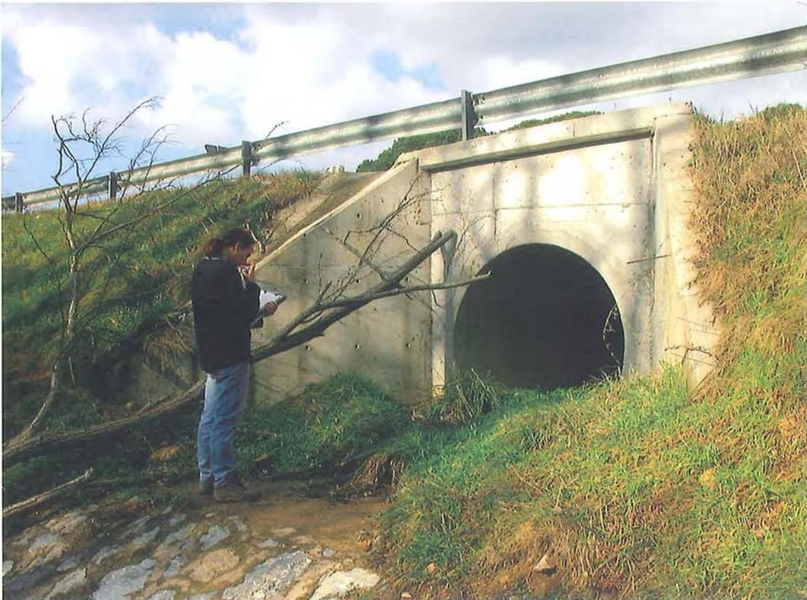
Figura 9.1 – El control de la efectividad de los pasos de fauna o el registro de los atropellos que se producen en una determinada infraestructura para localizar los puntos negros en los que se produce una excesiva mortalidad, se puede llevar a cabo mediante procedimientos estandarizados incluidos en los programas de mantenimiento de infraestructuras. (Foto de C. Rosell)
