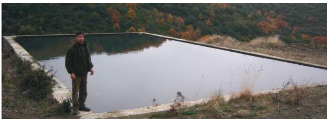
Lavadero adecuado como punto de agua.
