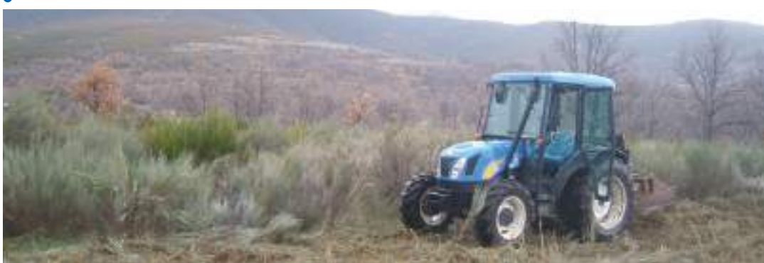
Apoyo en desbroces con maquinaria.
