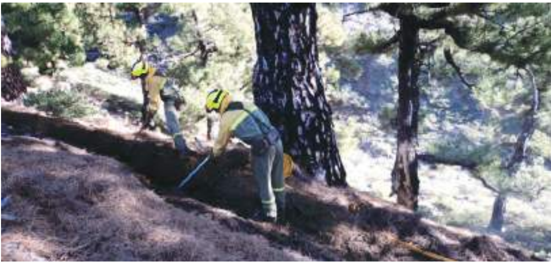
Preparación de parcela con herramientas manuales. Construcción de caballón.
