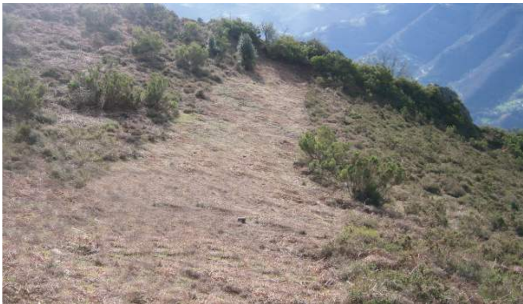
Detalle de los trabajos previos ejecutados.
