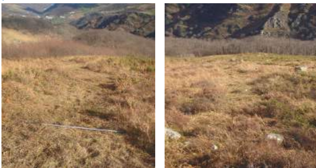
Detalle de la anchura del desbroce realizado.
