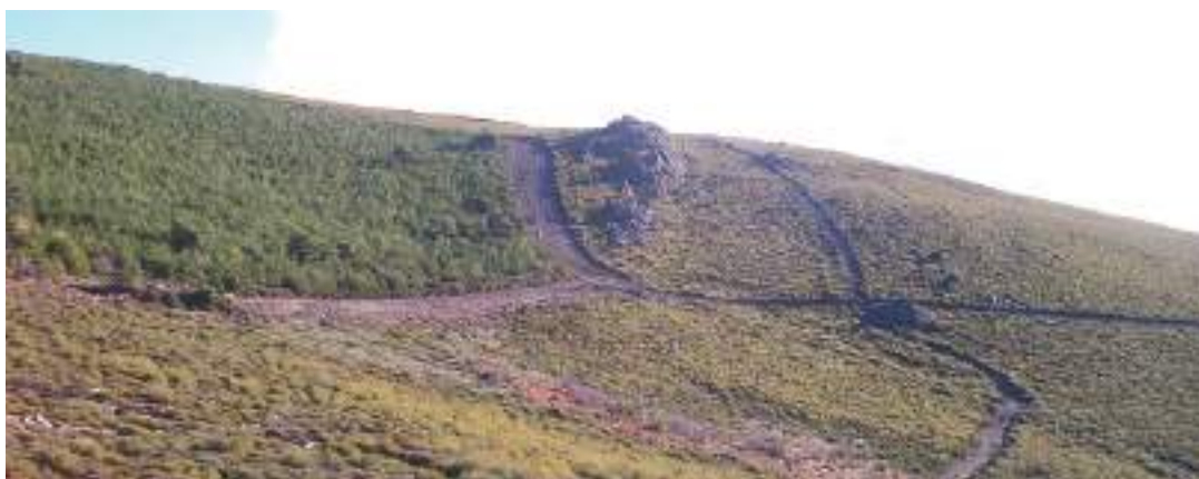
Cortafuegos existentes en la zona sureste de la masa.
