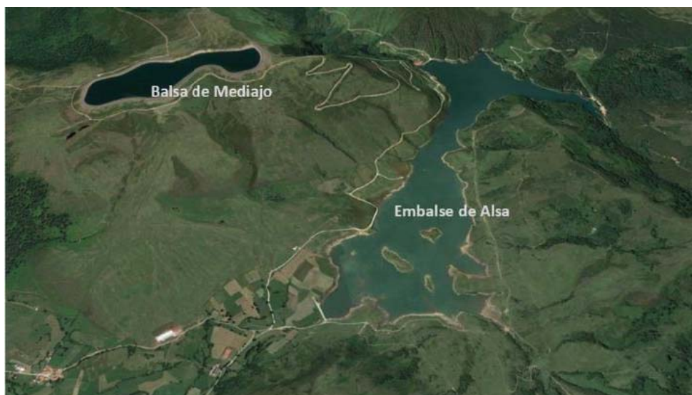
Figura 4. Panorámica aérea del embalse de Alsa y la balsa de Mediajo (zona de implantación de la ampliación de la CHR de Aguayo-Aguayo II)
