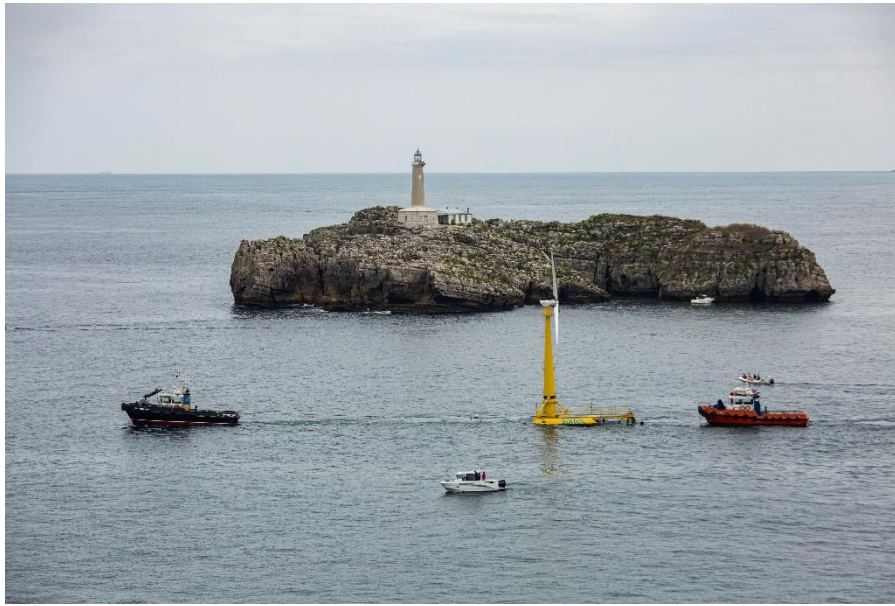
Figura 1. Prototipo de plataforma eólica flotante instalada en España (mar Cantábrico)
