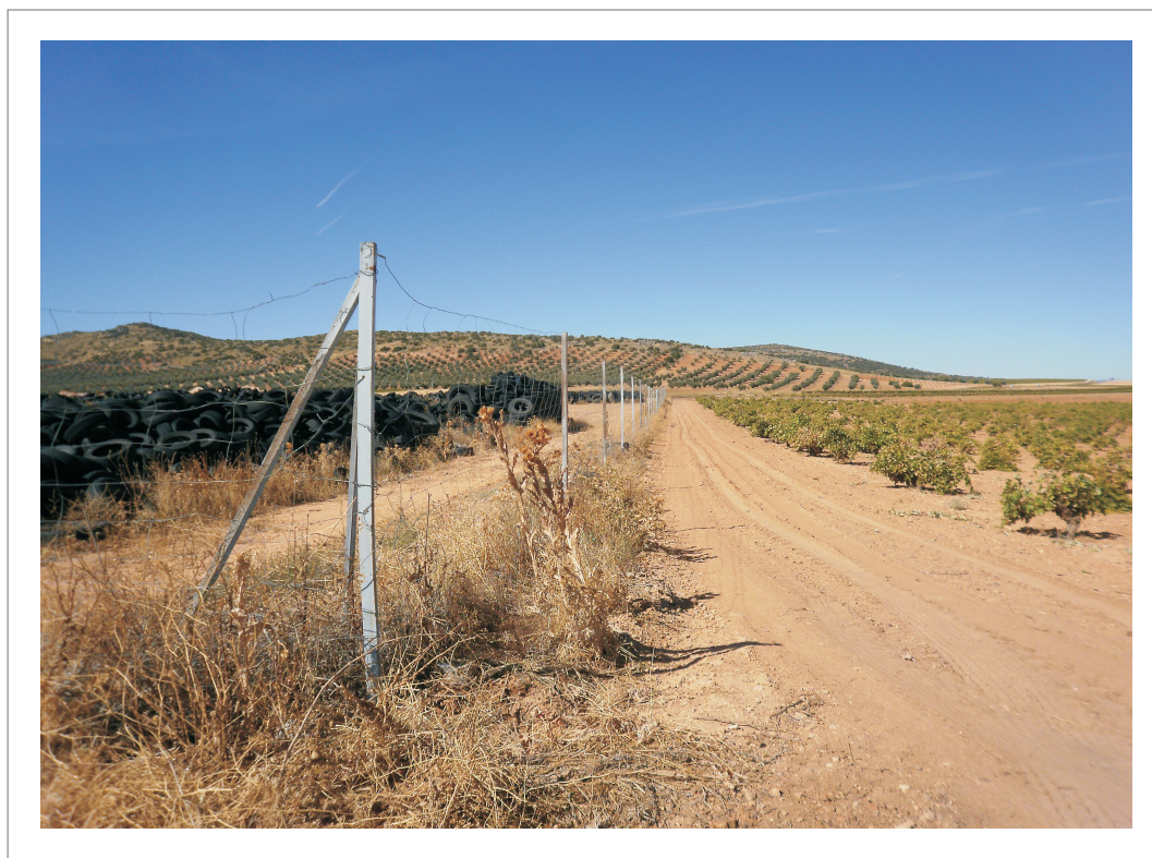
FOTOGRAFÍA 7. Cortafuegos exterior de un acopio de NFU
