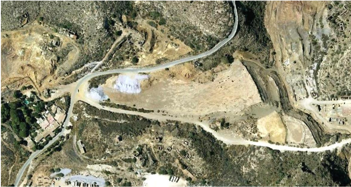
Figura 37. Imagen área de la presa minera El Gorguel (imagen obtenida en http://www2.ign.es/iberpix/visoriberpix/visorign.html , ©Instituto Geográfico Nacional). Pueden observarse unas acumulaciones de materiales blancos que, casualmente, deben ser los residuos de mármol empleados como encalantes antes de su extendido.
