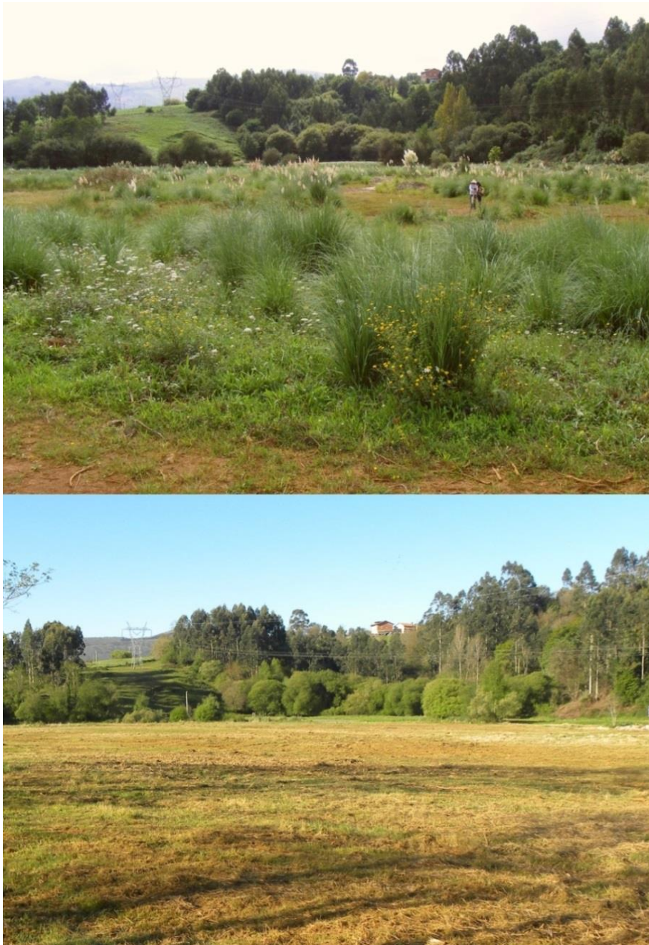
Figura 22. Arriba: superficie del Dique Gamonedo durante las labores de inventario de la presa en 2011. Abajo: la misma superficie en el año 2016, después de haber sido sometido a un desbroce superficial.
