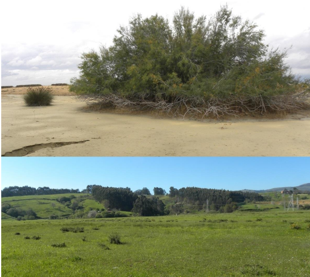
Figura 69. Arriba: efecto protector frente a la erosión eólica de la existencia de un taray ( Tamarix sp.), lo que puede apreciarse por el escalón generado por debajo de la copa del árbol, en la presa 805-II-4-001 (Castuera, Badajoz). Abajo: protección completa frente a la erosión proporcionada por una pradera sobre la superficie de la presa minera 34-III-4-001 (Cartes, Cantabria).
