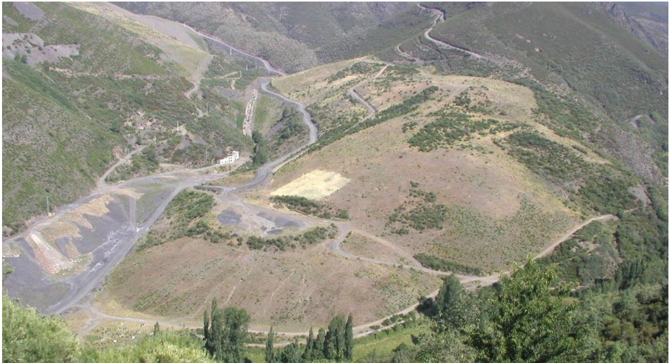
Parcelas experimentales sembradas de centeno (amarillo pálido) rodeadas de superficies hidrosebradas con mezclas de pratenses en escombreras de carbón remodeladas (Tremor de Arriba, León).
