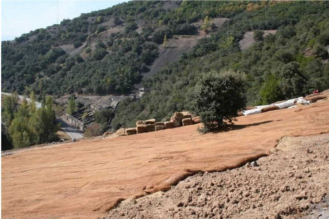
Figura 54. Fardos de heno sembrado (al fondo) y malla de coco extendida sobre la superficie de una de las escombreras de Arlanza (fotografía cedida por Avelino García Álvarez, CIEMAT).
