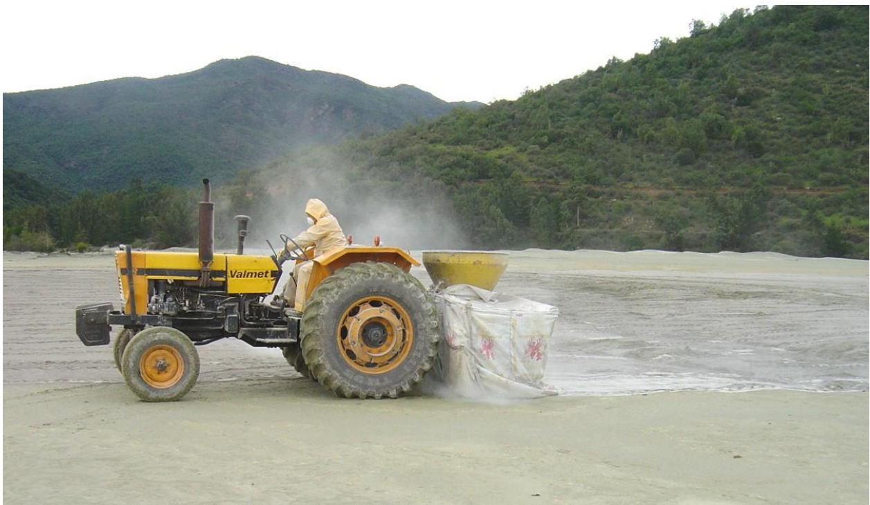
Distribución de enmienda caliza sobre la superficie de la presa minera Cauquenes (Chile). Fotografía cedida por Mauricio Lemus.
