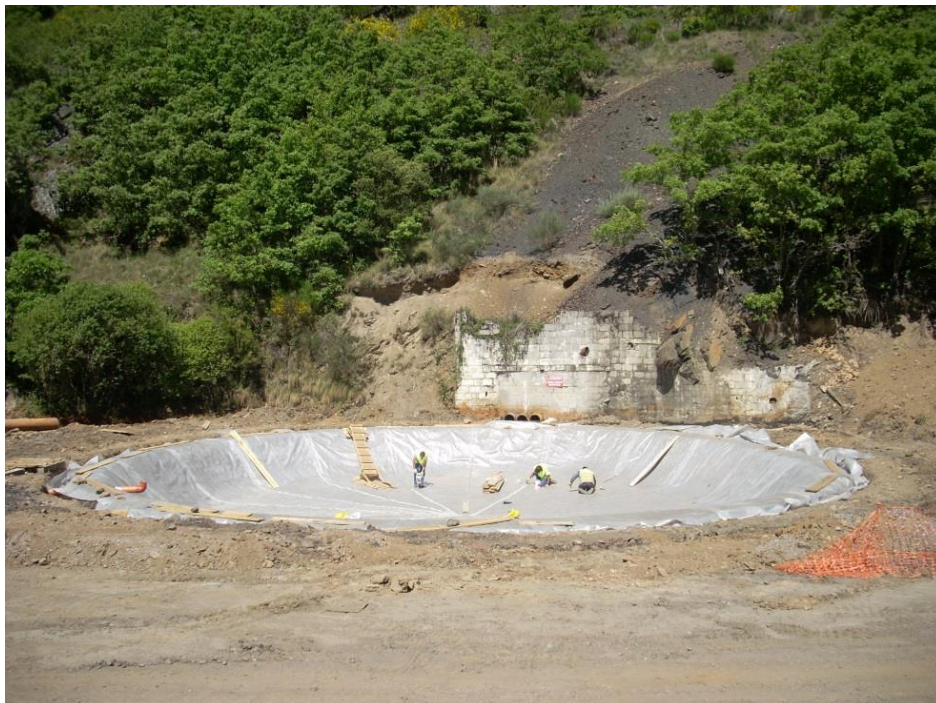
Construcción de un SAPS para tratar un drenaje de mina en Igüeña (León).
