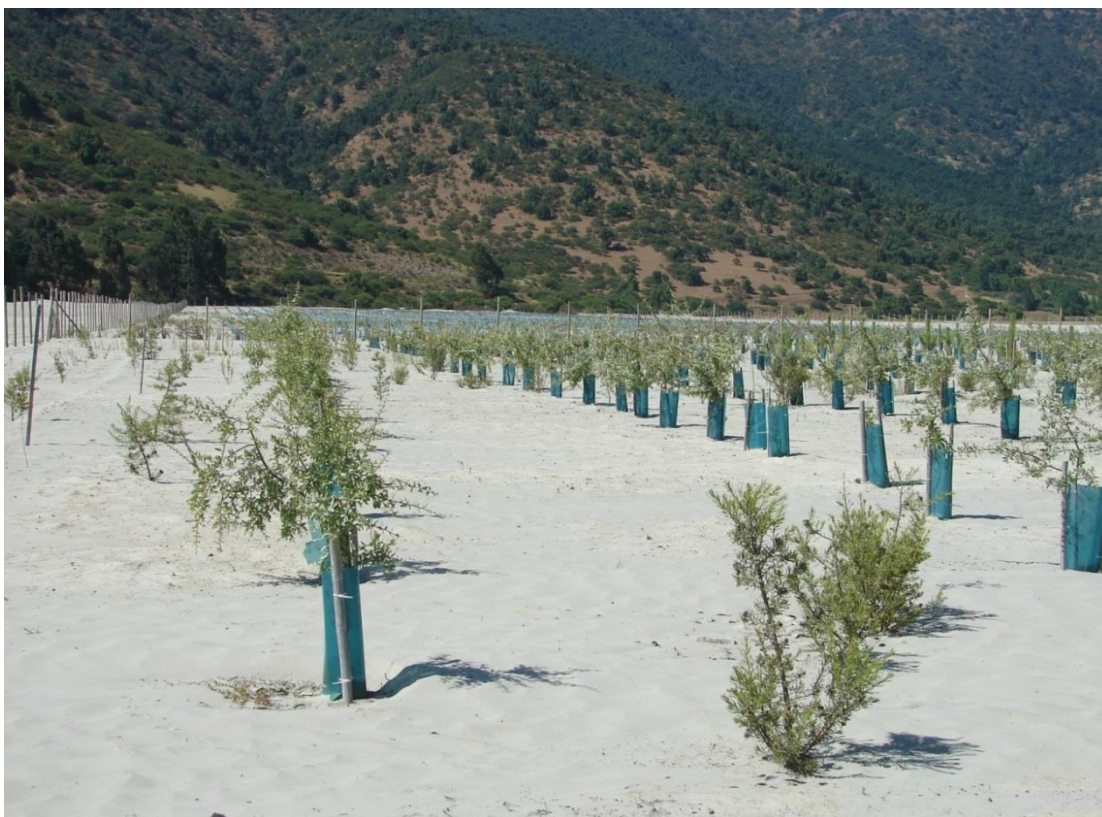
Figura 72. Plantaciones experimentales de vegetación nativa para la fitoestabilización de la presa minera (tranque de relaves) Cauquenes (Chile). Fotografía cedida por Mauricio Lemus.
