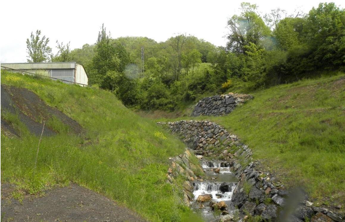
Figura 67. Canal perimetral (o de protección de un cauce natural) de una pequeña escombrera en Bárzana (Asturias), revestido de escollera y con pequeños saltos para reducir la energía de la corriente.
