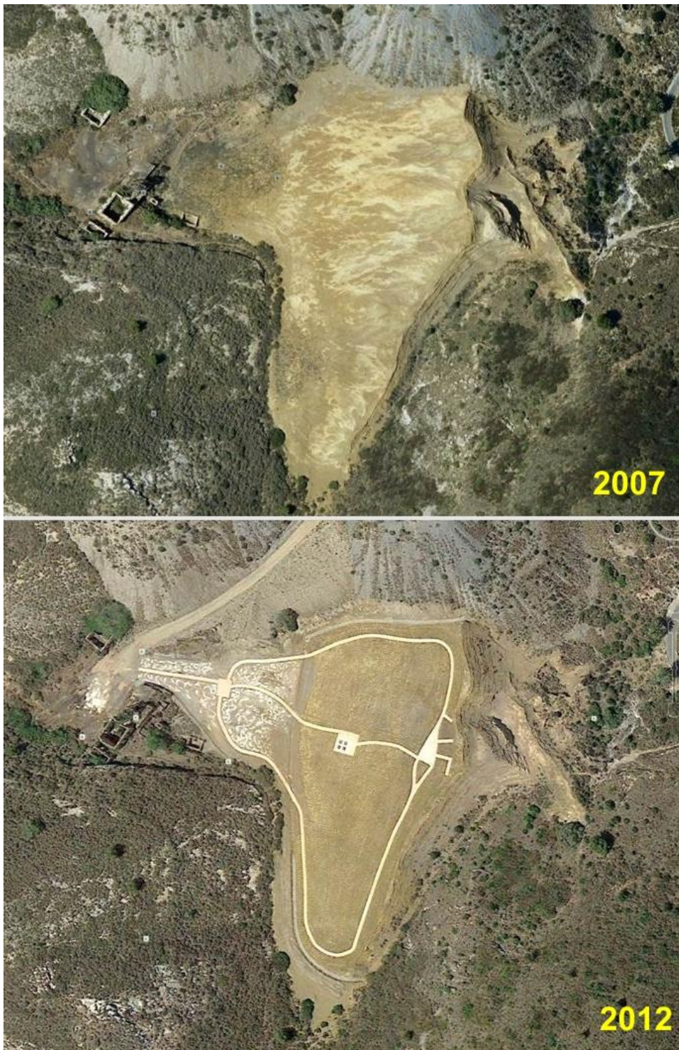
Figura 38. Fotografía aérea del depósito de Santa Antonieta en 2007 y en 2012. Fuente: Google Earth.
