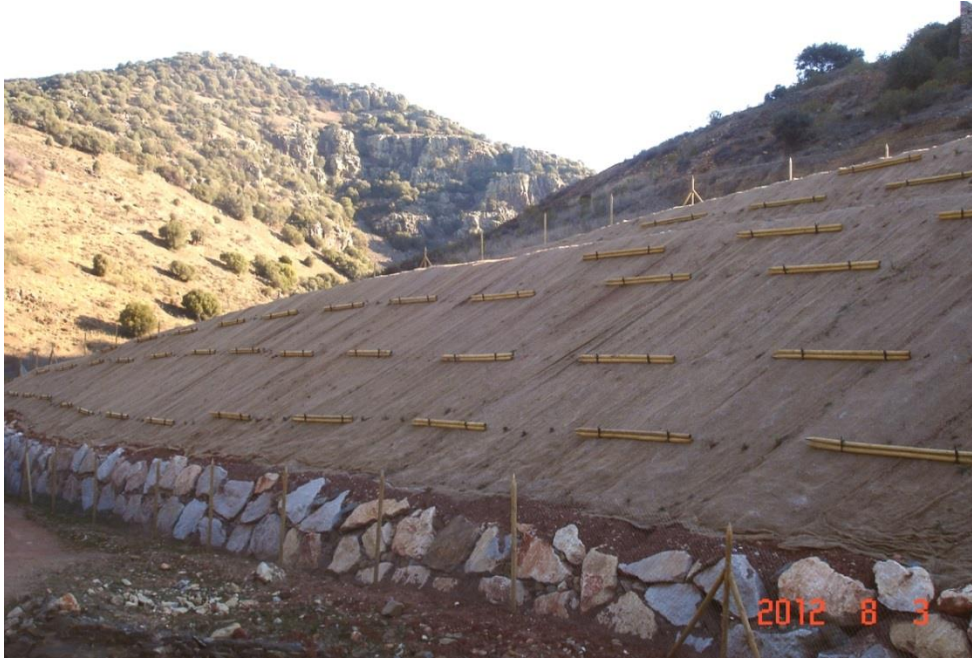
Pequeño muro de escollera que sostiene tierras aportadas sobre una presa minera en la zona de Bailén (Jaén).
