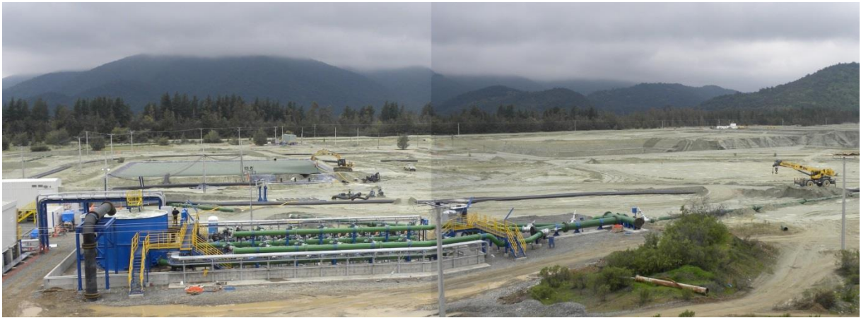
Figura 64. Instalaciones para el reprocesamiento de los residuos mineros de flotación de la presa minera Cauquenes (O'Higgins, Chile).
