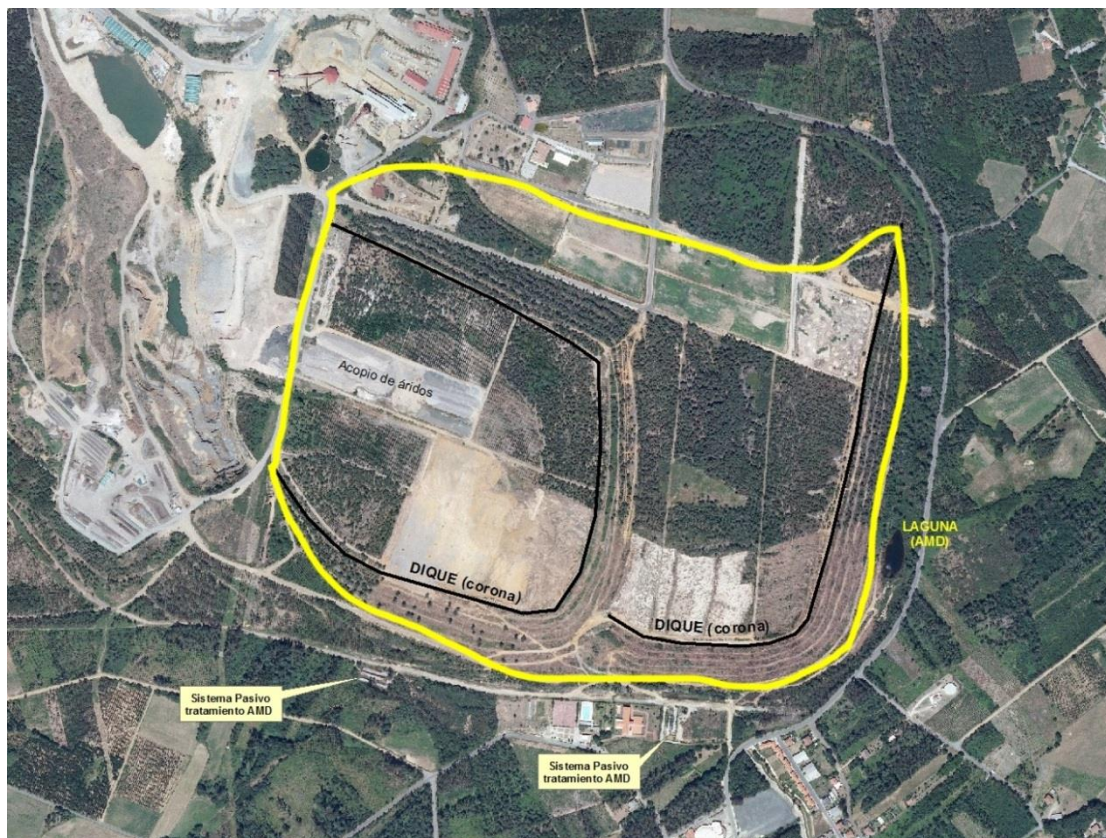
Figura 31. Fotografía aérea de las presas de lodos de la Mina de Touro en 2012 (imagen obtenida de Google Earth). La línea amarilla es una envolvente aproximada de la zona ocupada por residuos de flotación.
