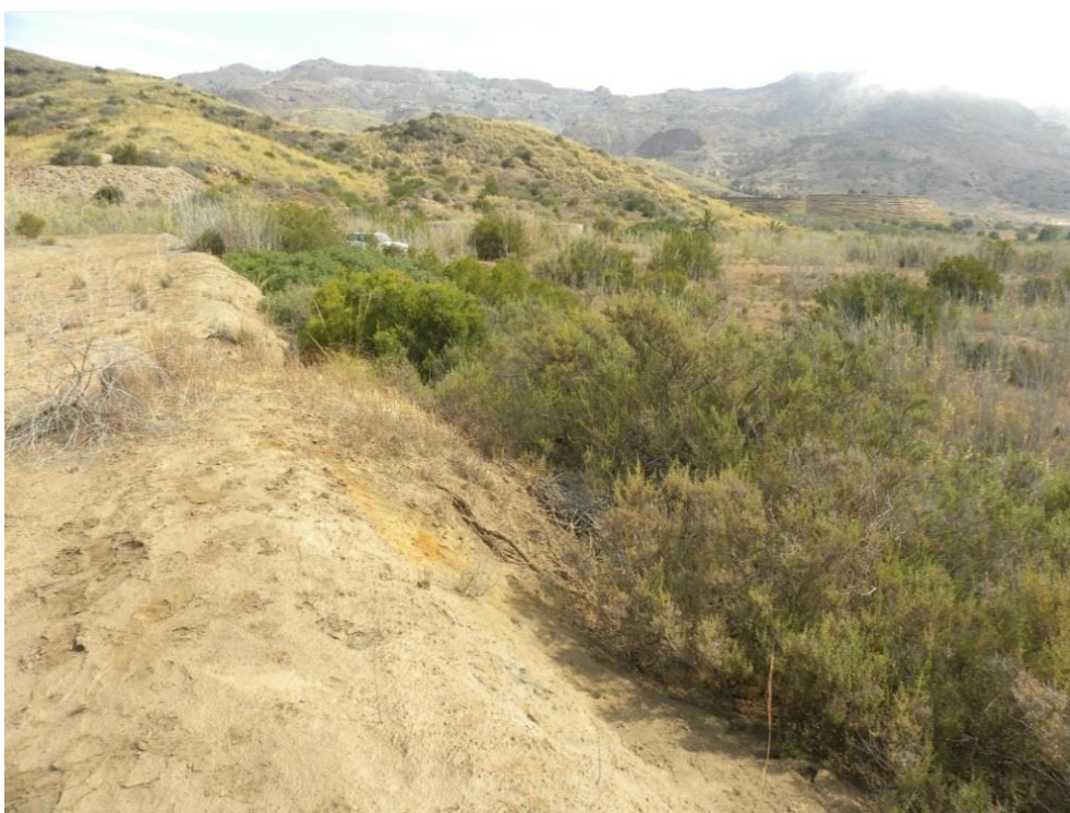
Figura 18. Vista de de la colonización arbustiva en el dique de la presa 977-II-4-030.
