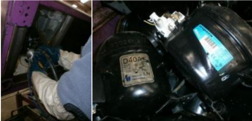
Fotografías 5.2.2.- Detalle de otro sistema de la extracción de gases refrigerantes y aceites del circuito a través de un orificio realizado en el compresor. Nótese que el compresor ha de estar ausente de aceite.
