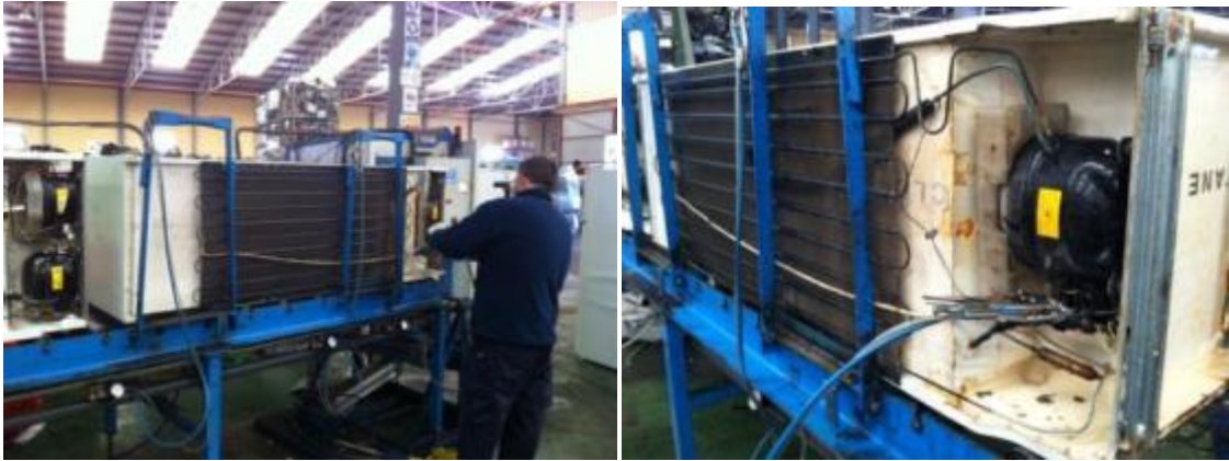
Fotografías 5.2.1.- Detalle de la retirada de cables y la extracción de gases refrigerantes y aceites.
