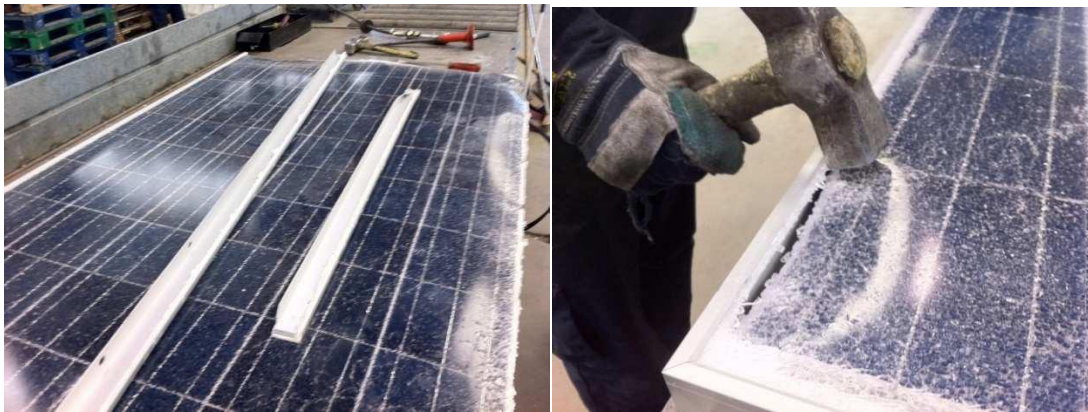
Fotografías 5.6.2.- Retirada de la carcasa exterior.
