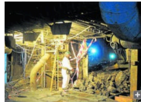
Un momento de los trabajos en el horno flash.
