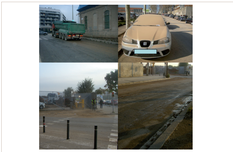
Barcelona, Zona Universitaria, obra pública, 2008 (superior derecha). Barcelona, obras alrededor estación AVE Sagrera, 2010 (resto de imágenes).
