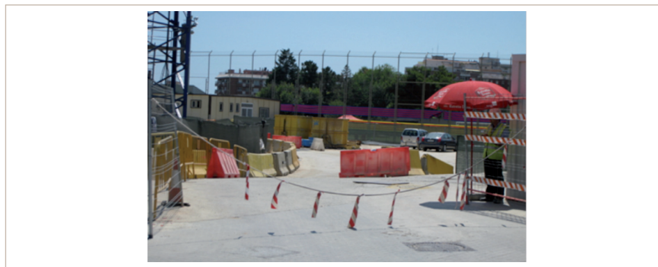
Figura 4.20. Encargado de obra en control del registro de vehículos y actividades diarias en la zona de actividad constructora
