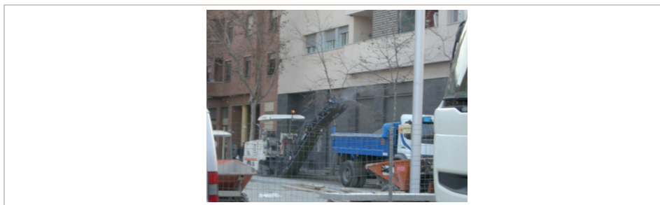
Figura 4.19. Ejemplos de emisiones de polvo por el rascado de un firme de rodadura antiguo y la carga del rascado en la bañera del vehículo
