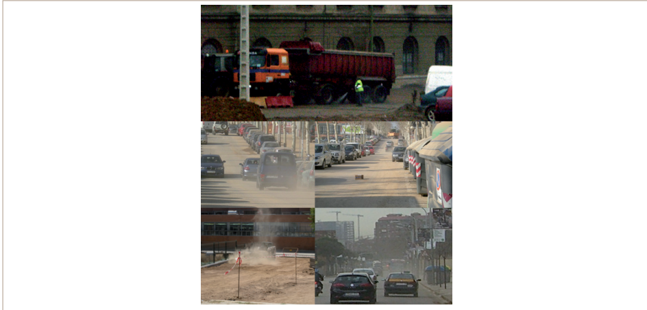
Figura 4.17. Área habilitada para el lavado de camiones a la salida obras estación del AVE Sagrera, Barcelona, 2009 (superior). Resuspensión de polvo producida por el tráfico "off road" de la obra en zona sin pavimentar y por el tráfico en la Zona Universitaria Barcelona (2008) y en la calle Sagrera (Barcelona) debido a las emisiones de las obras de la estación del AVE (derecha inferior, 2010)
