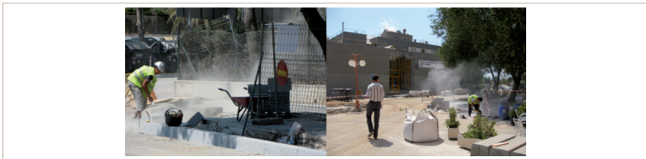
Figura 4.18. Ejemplos de emisiones de polvo por el corte de material de obra sin la utilización de riego simultáneo, ni medidas protectoras para la exposición personal
