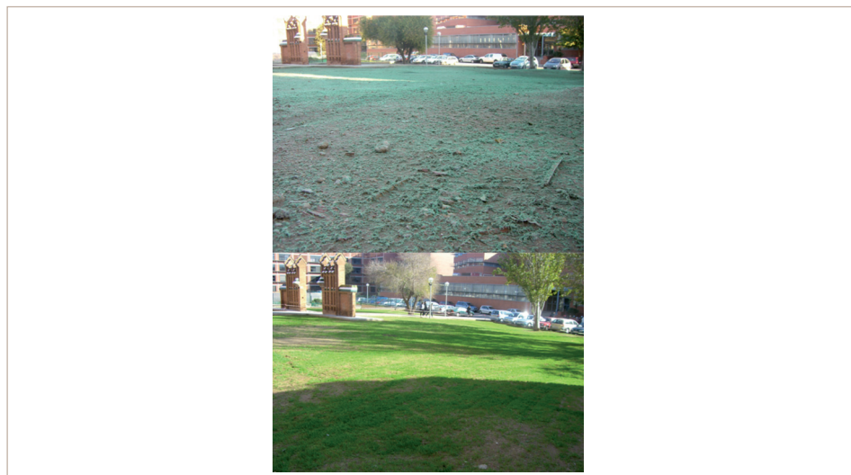
Figura 4.15. Efecto estabilizador del polvo en superficie por hidrosiembra en una zona recién excavada en la Zona Universitaria de Barcelona, obra pública 2009
