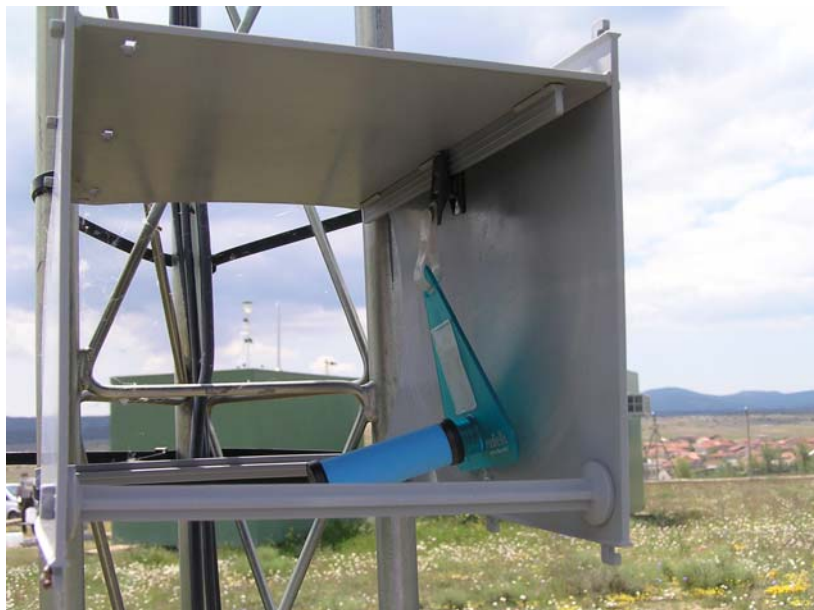
Figura 3.3. Equipo de medición pasivo de amoníaco (medición indicativa).
