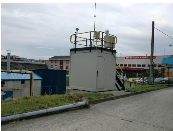
Imagen 7. Estación A Grela, en A Coruña.
