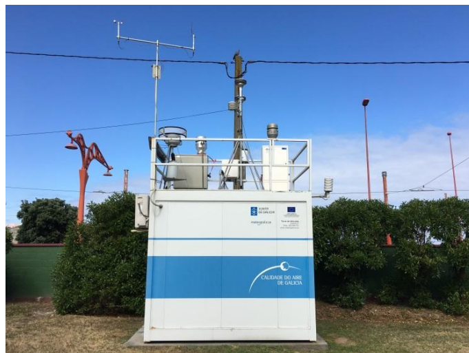
Imagen 4. Estación Torre de Hércules, en A Coruña
