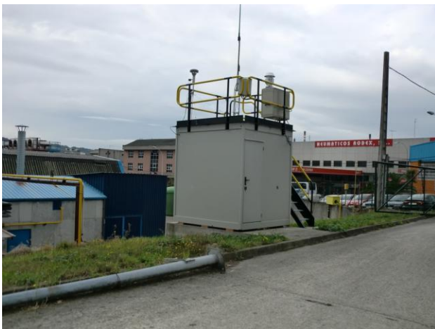
Imagen 8. Estación A Grela, en A Coruña.
