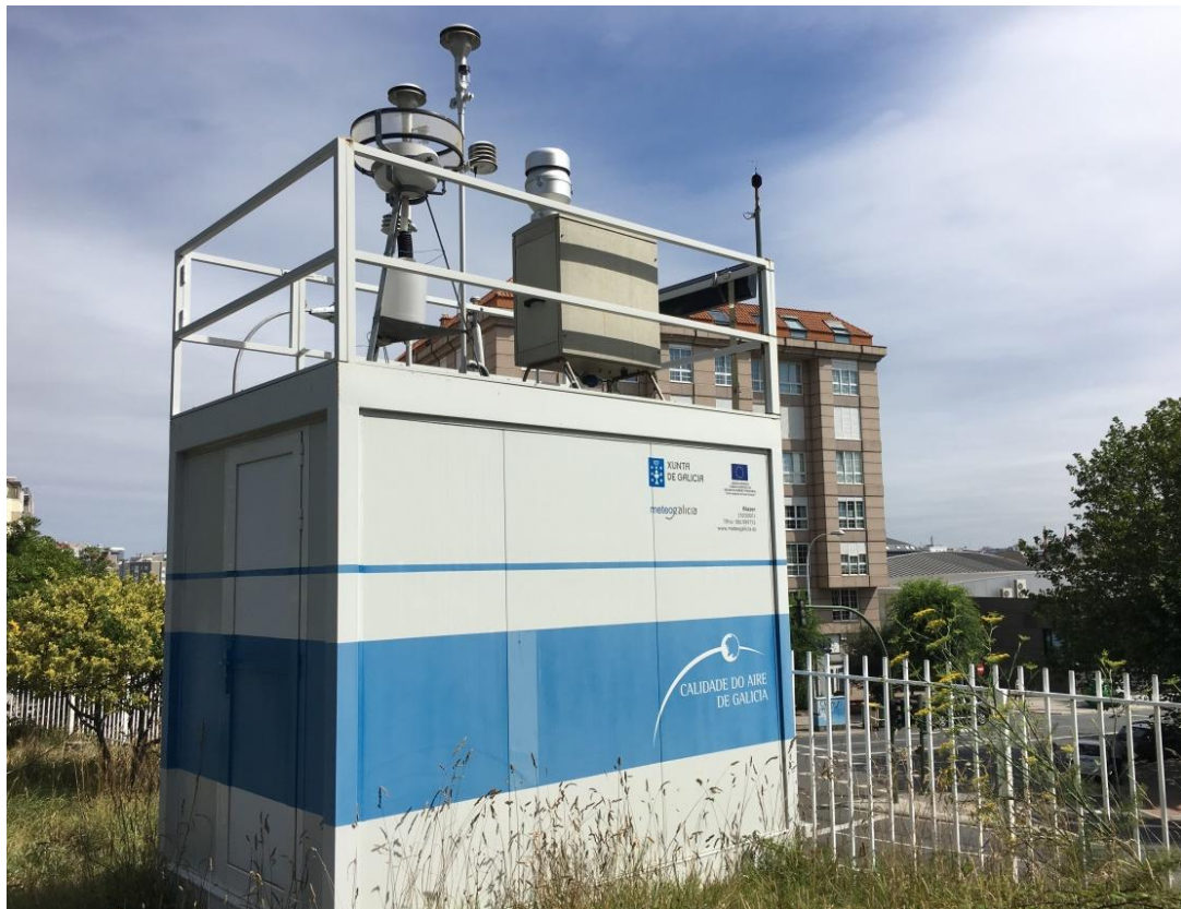
Imagen 19. CAV-A/MSB MCV con cabezal PM 10 en la estación Riazor
