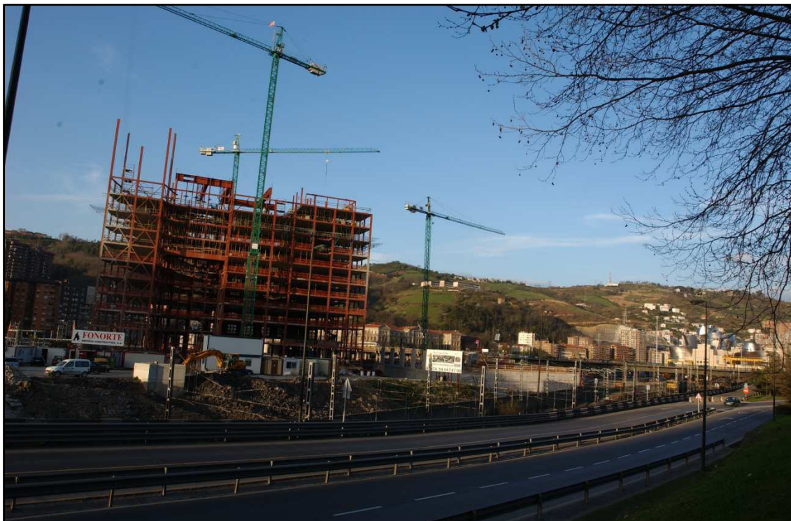
Figura 17. Obras en la Villa de Bilbao. 'CC BY-3.0-ES 2012/EJ-GV/Irekiá-Eusko Jaurlaritzá/Mikel Arrazola'
