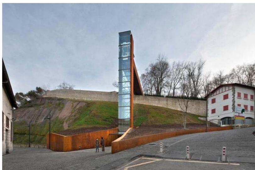
Con objeto de mejorar la accesibilidad entre el Parque de la Media Luna y el Paseo Fluvial de Pamplona, con un gran desnivel entre ambos (casi 21 m), se decidió la instalación de una torre elevador exenta, comunicada con el acceso mediante una pasarela.
