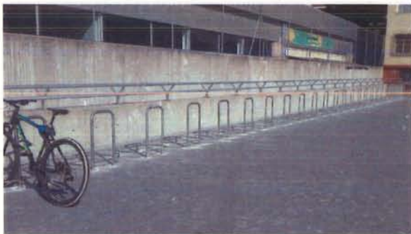
Colocación de aparcabicis
