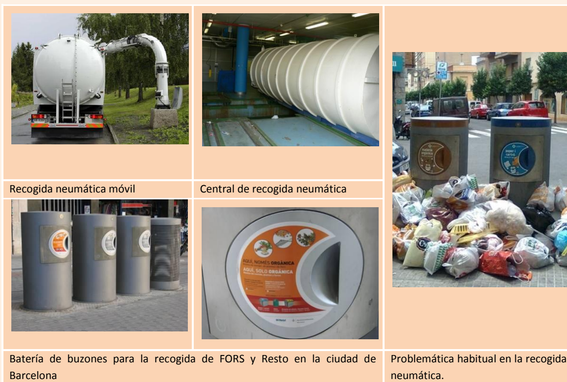
Figura 19. Recogida selectiva mediante sistema neumático.
