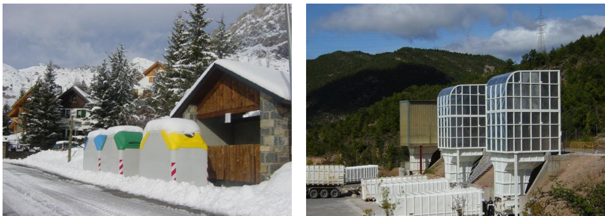
Figura 13. Instalaciones para la recogida de residuos en la comarca del Alto Gállego: área de aportación de residuos en Formigal y planta de transferencia de Sabiñánigo.
