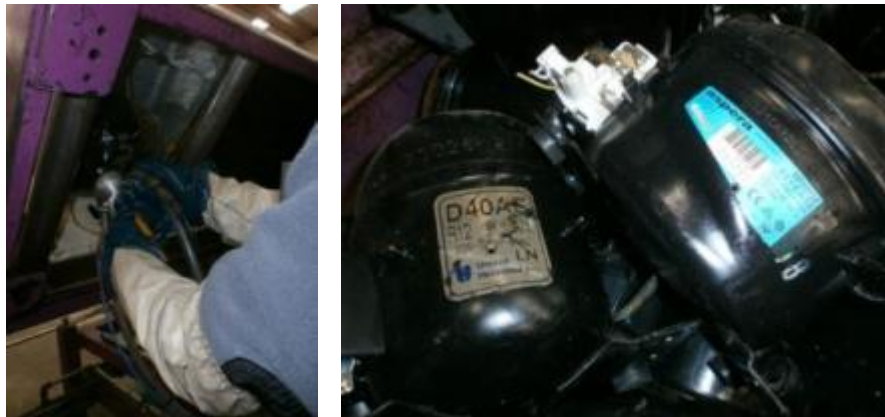
Fotografías 5.2.3.- Detalle de otro sistema de la extracción de gases refrigerantes y aceites del circuito a través de un orificio realizado en el compresor. Nótese que el compresor ha de estar limpio de aceite.
