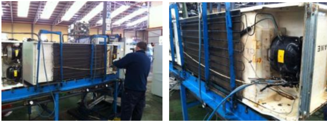
Fotografías 5.2.2.- Detalle de la retirada de cables y la extracción de gases refrigerantes y aceites.
