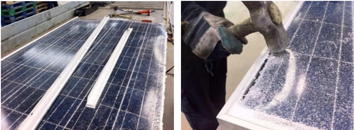
Fotografías 5.6.2.- Retirada de la carcasa exterior.
