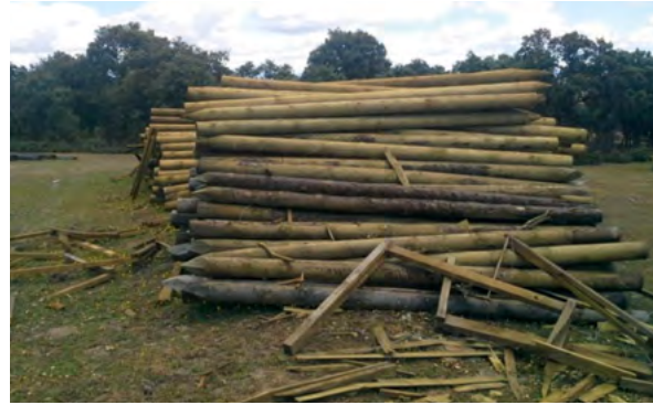
Postes de madera tratada empelados durante la ejecución de las obras.
