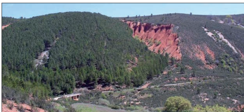
Foto 16.-Resultados de una repoblación de objetivo hidrológico-forestal (izquierda) en comparación con el estado de la ladera sin repoblar. Retiendas (Guadalajara). Foto Serrada.
