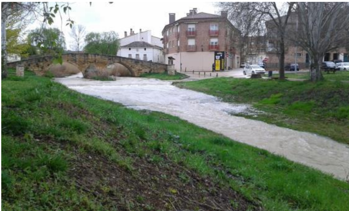
Fotografía de crecida del río Iranzu a su paso por el puente romano y el parque inundable de la localidad de Villatuerta. Fuente: Ayuntamiento de Villatuerta.
