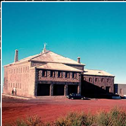
Entre 1940 y 1951 Font pasó largas temporadas aislado en el Observatorio de Izaña, a 2300 metros de altitud. Fue allí, como él mismo cuenta, donde desarrolló su interés por la climatología. En la foto el observatorio en los años 60 con el mismo aspecto que cuando lo habitaba Font.
