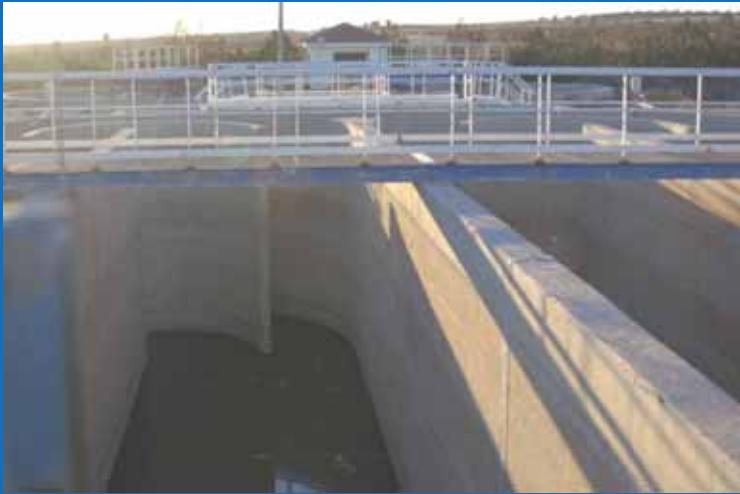
Canales del tratamiento secundario de la depuradora de Quero (Toledo), ahora sin funcionamiento (foto: GIA).
