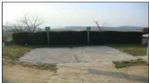
CONEXION CON ITINERARIO PEATONAL ACCESIBLE. LA ARENA INVADIE EL ITINERARIO.
