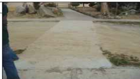
CONEXION CON ITINERARIO PEATONAL ACCESIBLE. TRAMO DE HORMIGÓN EXISTENTE ENSANCHADO A 1,80 M. MANTENIMIENTO PARA EVITAR QUE LA TIERRA INVADA EL RECORRIDO.
