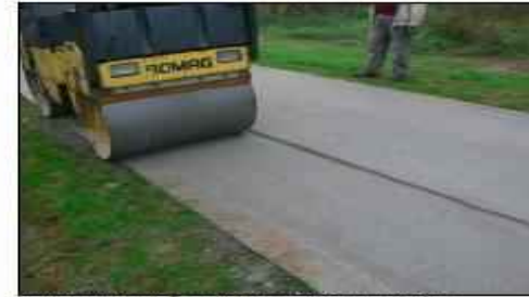
PAVIMENTO NATURAL ARENA+RECICLADO VIDRIO BORDILLOS ENRASADOS
