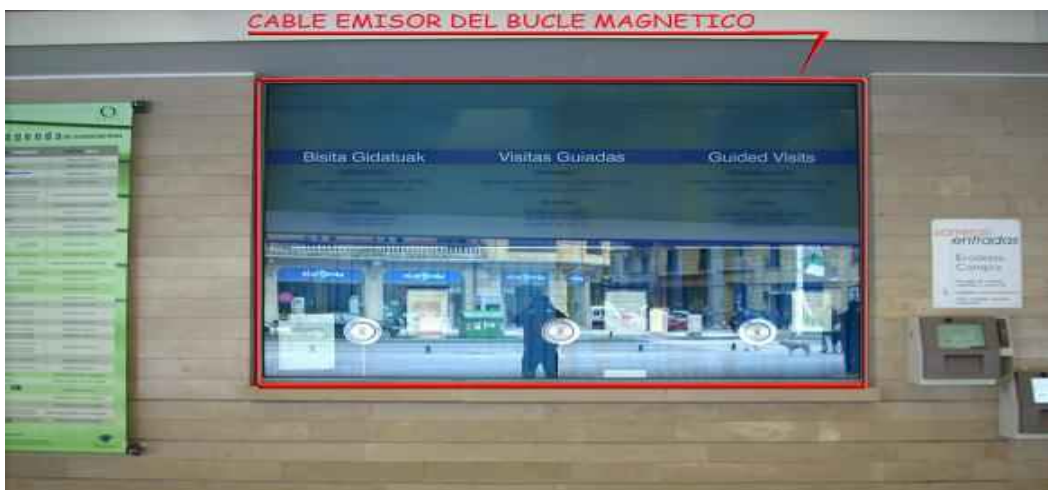
INSTALACIÓN DE BUCLE MAGNÉTICO EN TAQUILLAS ACRISTALADAS
