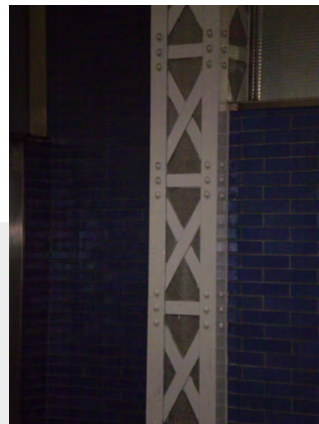
Pilar metálico roblonado en rehabilitación
