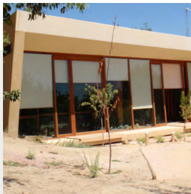
Elemento de protección solar
