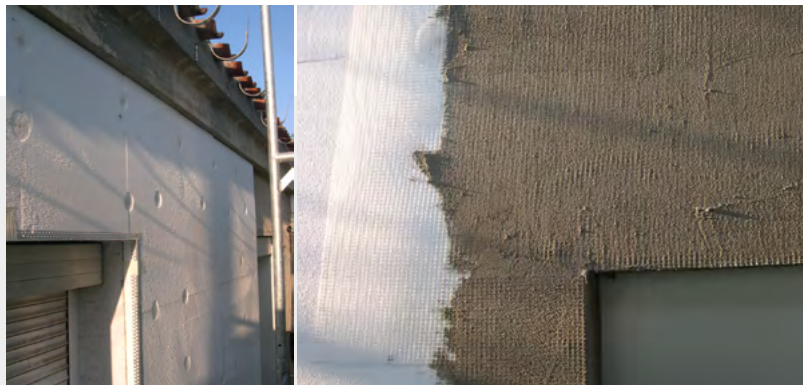
Montando SATE en rehabilitación de fachada
