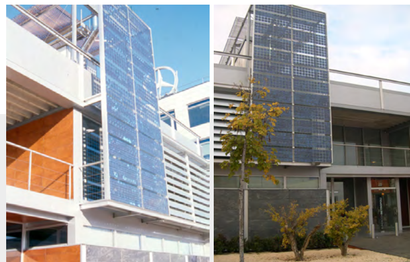
Módulo fotovoltaico en fachada
