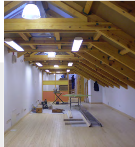
Estructura de madera
