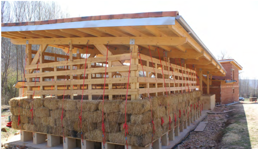
Construcción con balas de paja
