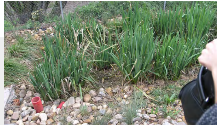
Sistema de depuración biológica de aguas residuales
