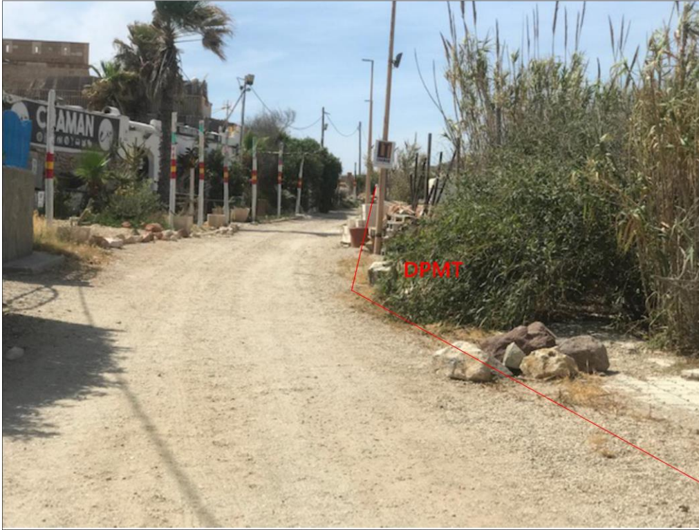
Fotografía 4. Deslinde del DPMT entre los vértices M-261 y M-262.
