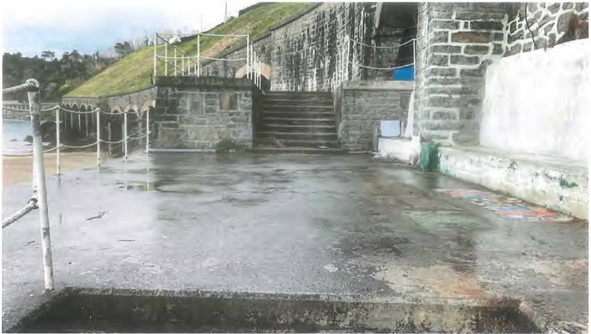
Vista plataforma +0.80 donde se situará el chiringuito de madera (8,75m 2 ), office (3,30m 2 ), zona de basuras (9m 2 ), una mesa (2m 2 ) y la terraza-1 (8,70m 2 )
