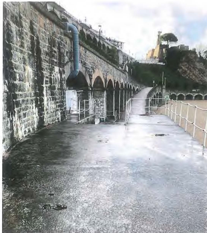
Vista plataforma +2.40 donde se situará la terraza-2 (25m 2 )
