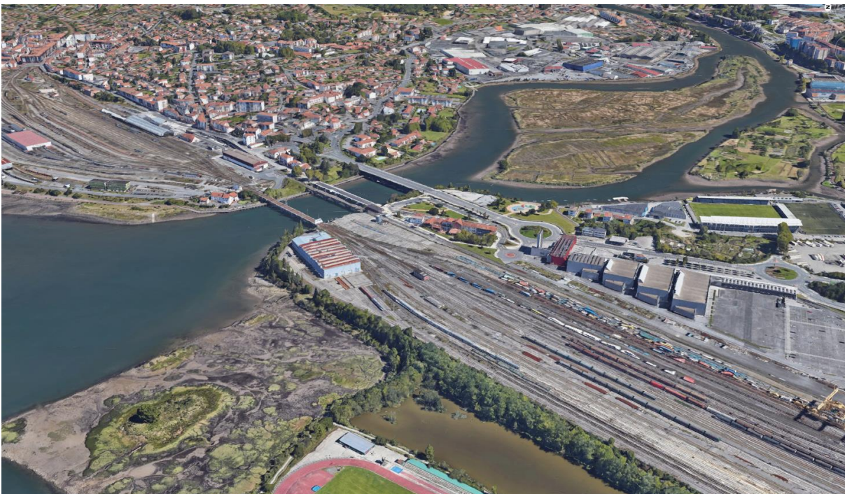
Figura 50. Vista aérea del puente entre otros tres puentes entre zonas de instalaciones ferroviarias
