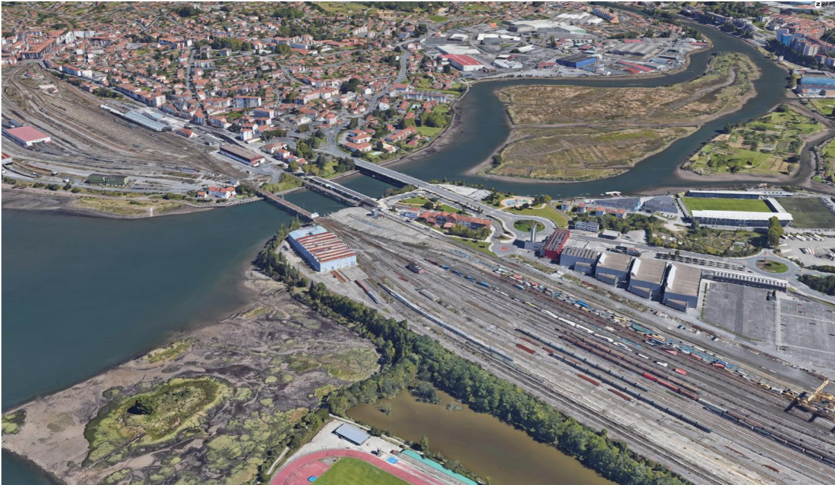
Figura 39. Vista aérea del puente entre otros tres puentes entre zonas de instalaciones ferroviarias
