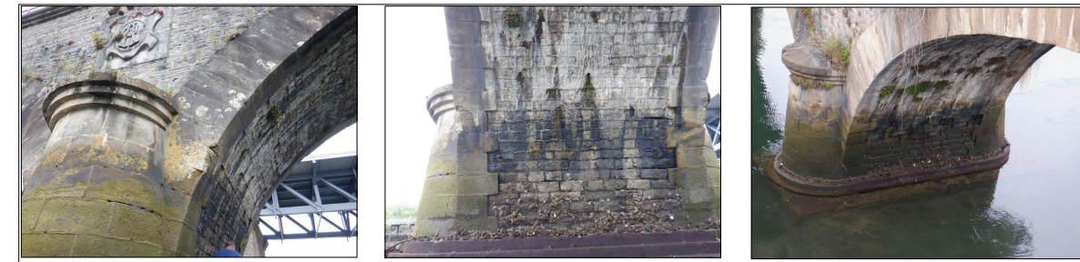
ACTUACION 4: LIMPIEZA DE HUMEDADES
