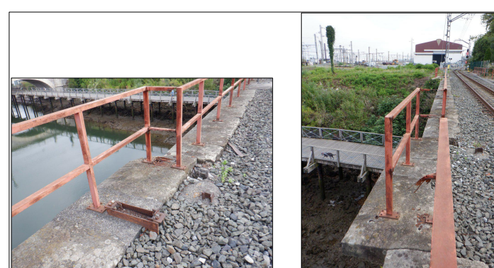
ACTUACION 6: REPARACION BARANDILLA SOBRE IMPOSTA
