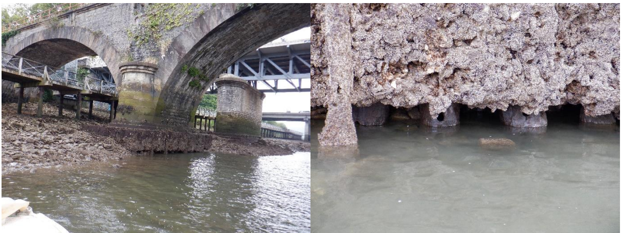
Figura 15. Pila 4 con pilotes de madera al aire
