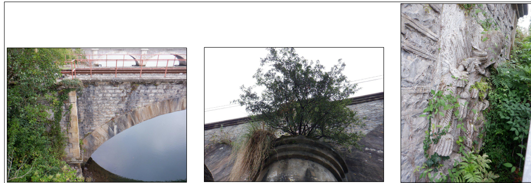
ACTUACION 2: ELIMINACION DE VEGETACION ENRAIZADA
