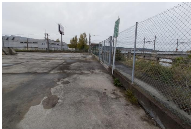
Figura 16. Zona planteada para instalaciones de obra y suministro de material. Cerramiento a retirar
