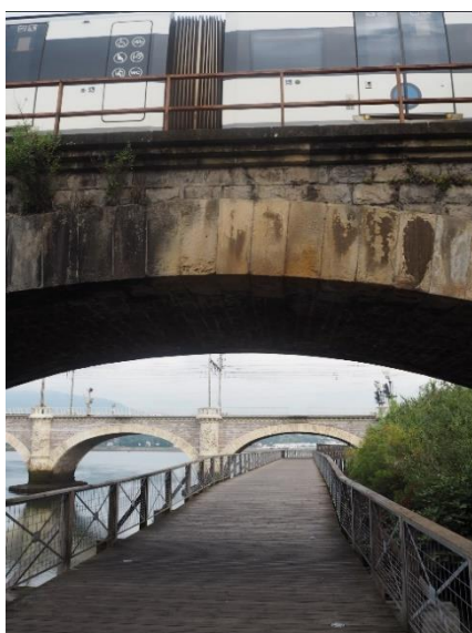
Figura 7. Vista aguas abajo desde pasarela
