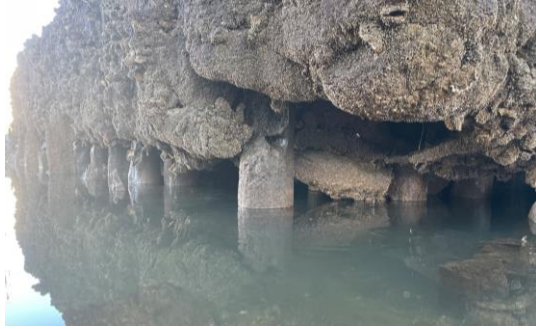
Figura 12. Pila 4. Socavación
