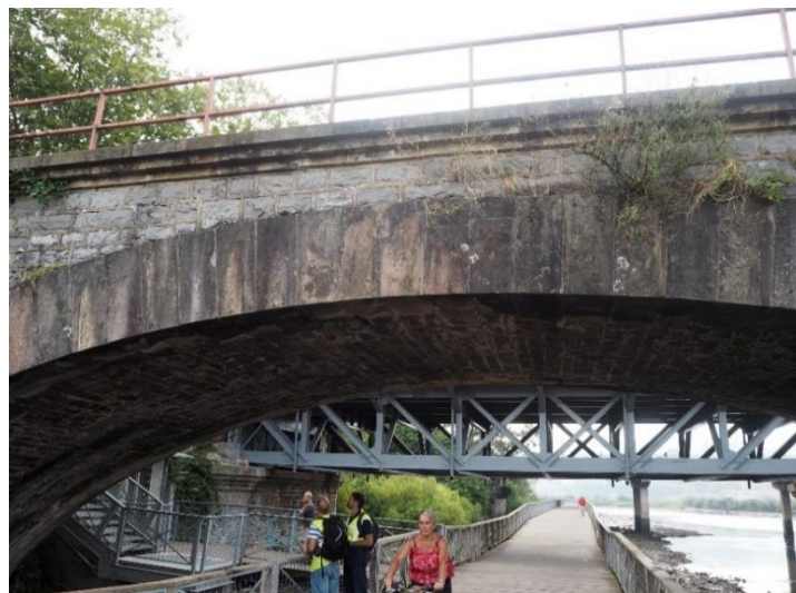
Figura 12. Vista aguas arriba desde pasarela
