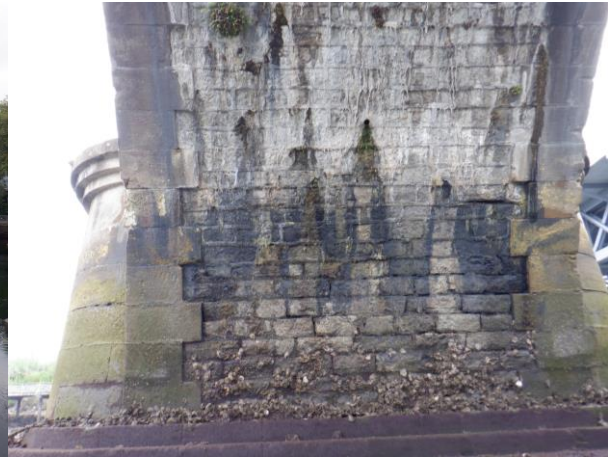
Figura 5. Vista transversal de bóveda
