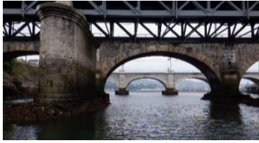
Figura 13. Vista aguas arriba desde embarcación
