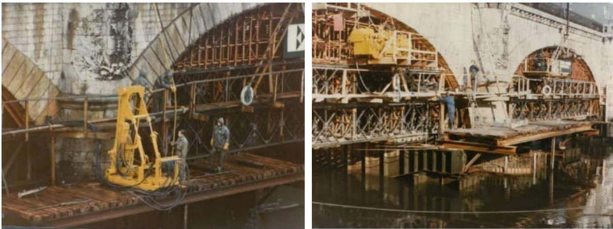
Figura 51. Refuerzo mediante micropilotes realizado en el puente de ADIF
