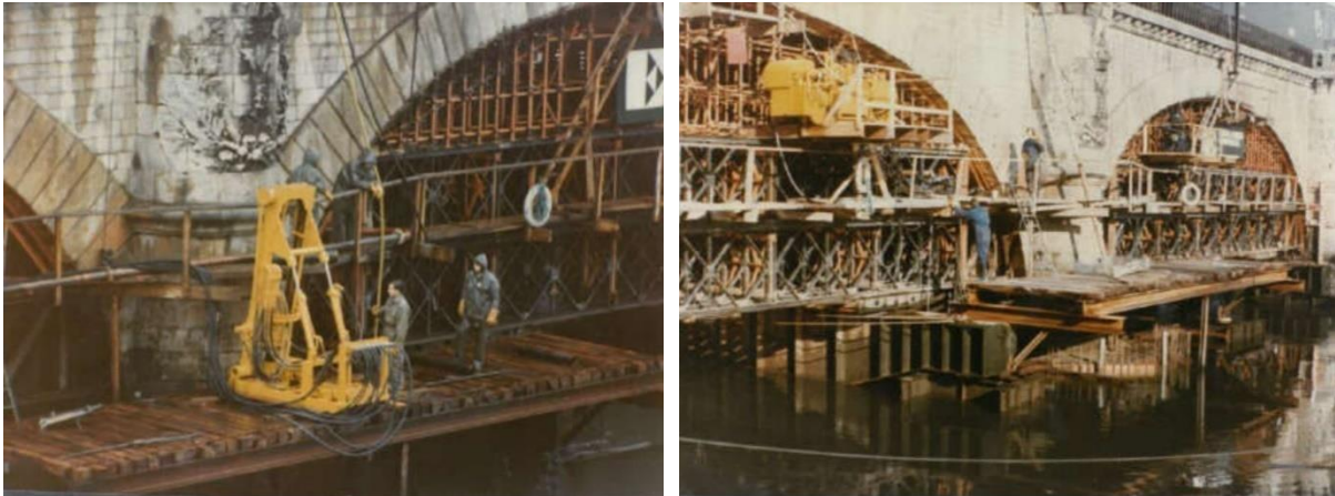
Figura 46. Refuerzo mediante micropilotes realizado en el puente de ADIF
