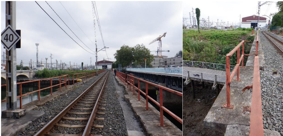
Figura 19. Vista superestructura y apartaderos en pila
