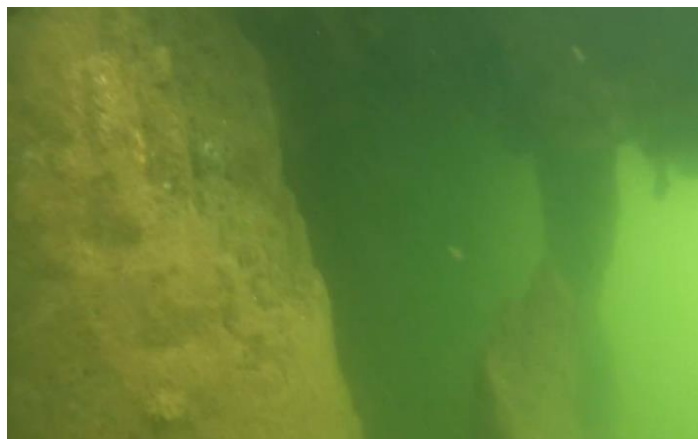
Figura 27. Pila 1. Cavity bajo encepado de pila 1
