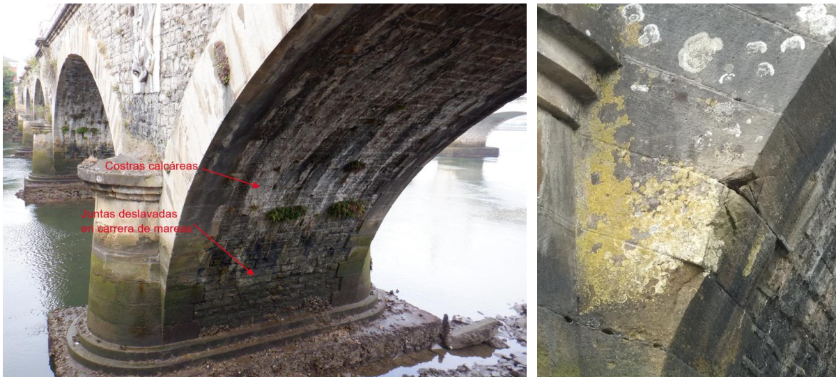
Figura 29. Afecciones bóvedas
