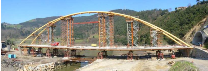
Figura 67. Motas de tierra para ejecución de puente sobre la ría Deba, en Gipuzkoa. Año 2007
