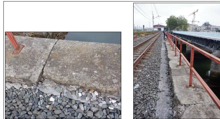
ACTUACION 5: REPARACION DE IMPOSTA
