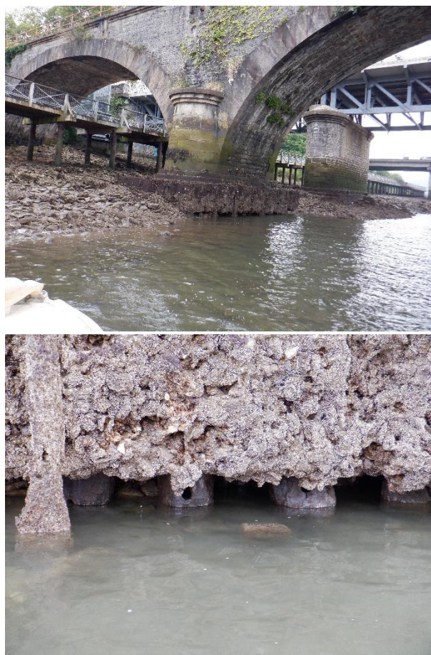
Figura 19. Pila 4 con pilotes de madera al aire
