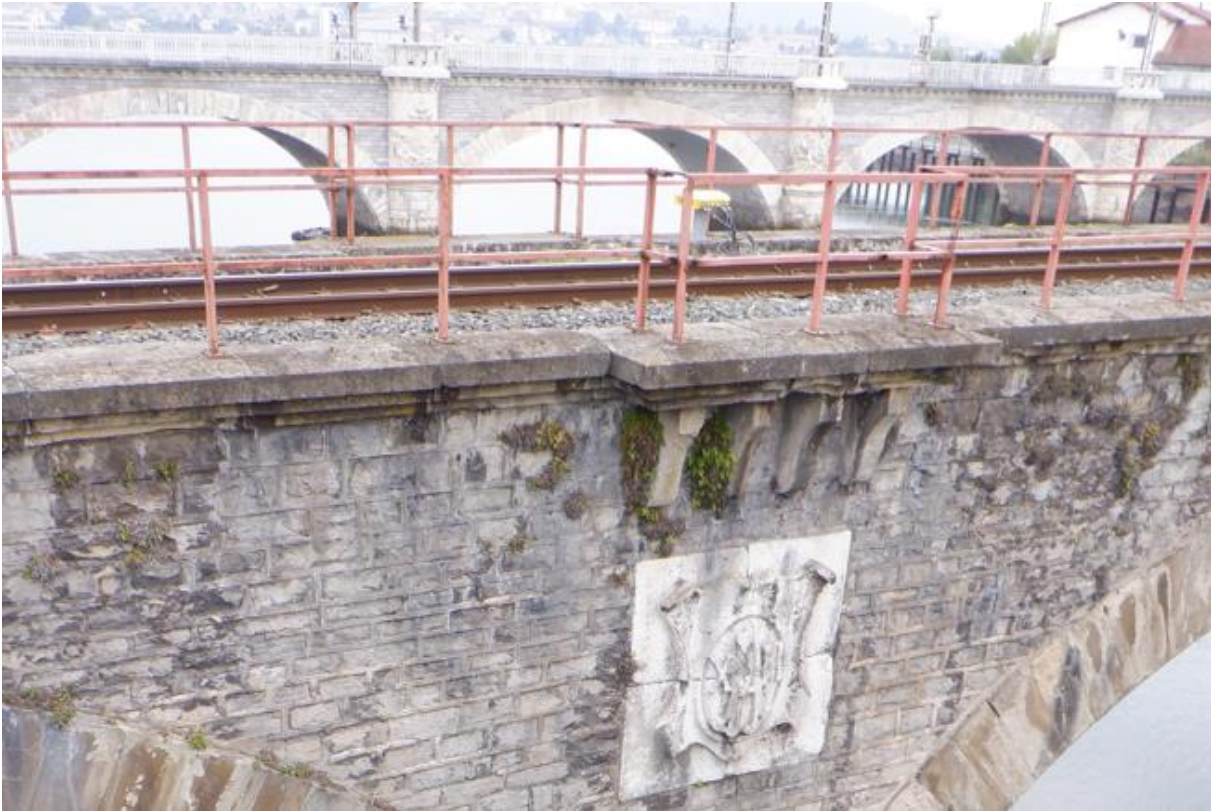
Figura 18. Viguetas descansillos en pilas
