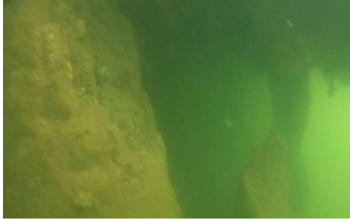
Figura 31. Pila 1. Cavity bajo encepado de pila 1
