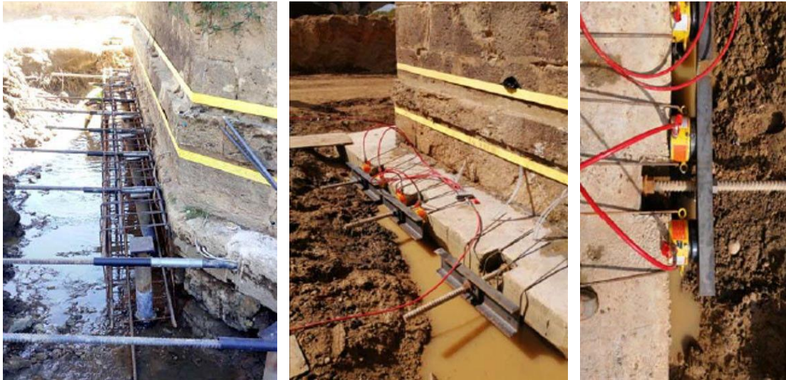
Figura 64. Recalce micropilotes de forma perimetral y tesado de pasadores para transmisión de esfuerzos
