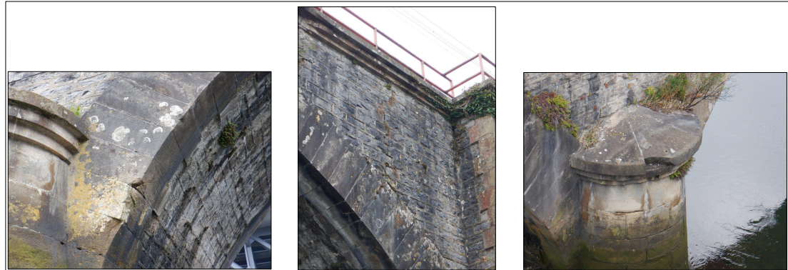
ACTUACION 3: REJUNTADO, REPOSICION Y RECONSTRUCCION DE SILLARES
