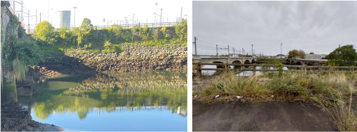
Figura 35. Zona de acceso entre puentes
