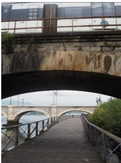
Figura 11. Vista aguas abajo desde pasarela
