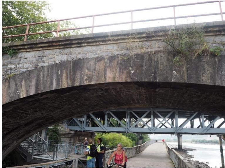
Figura 8. Vista aguas arriba desde pasarela
