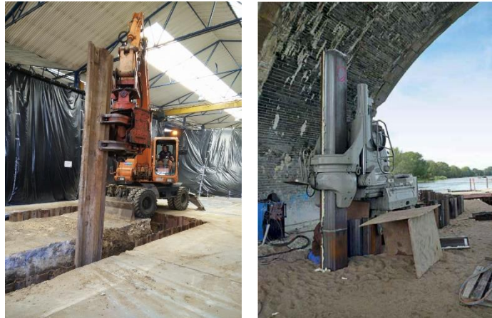
Figura 58. Vibrohincador lateral (izquierda) y equipo de hincado hidráulico (derecha)
