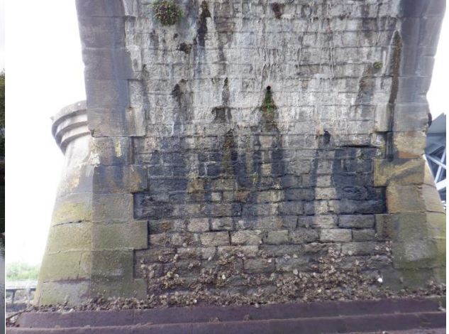
Figura 14. Vista transversal de bóveda
