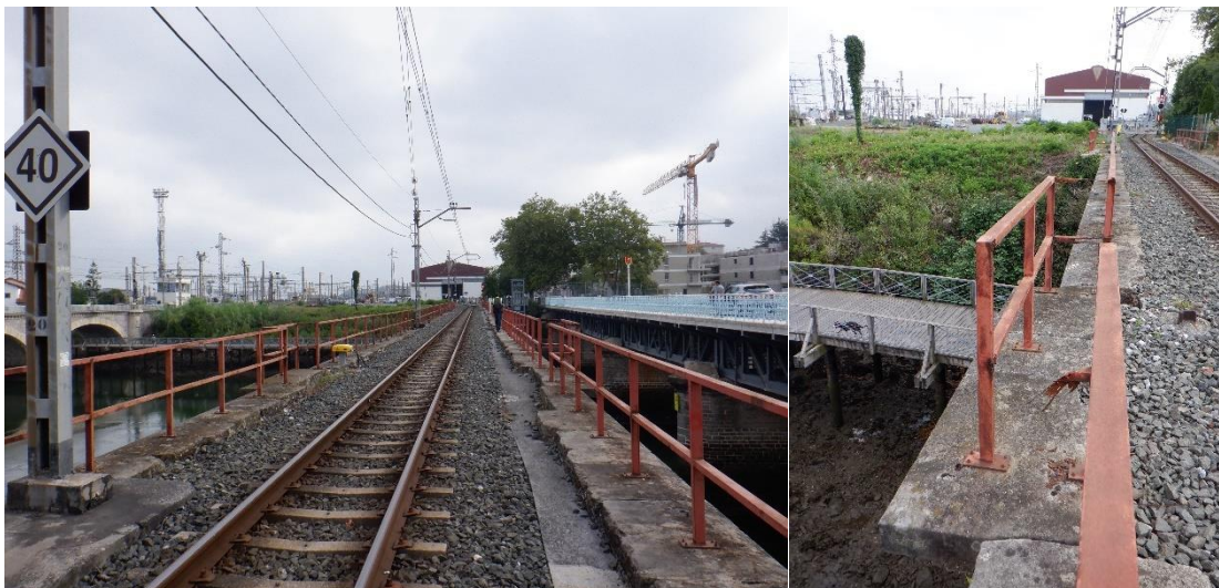
Figura 17. Vista superestructura y apartaderos en pila
