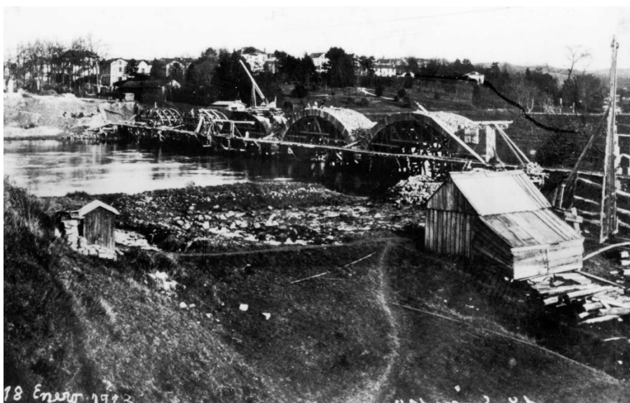
Figura 1. Cimbras para ejecución de bóvedas del puente Internacion en Irún de ETS, visto desde Irún (18 enero 1913)
