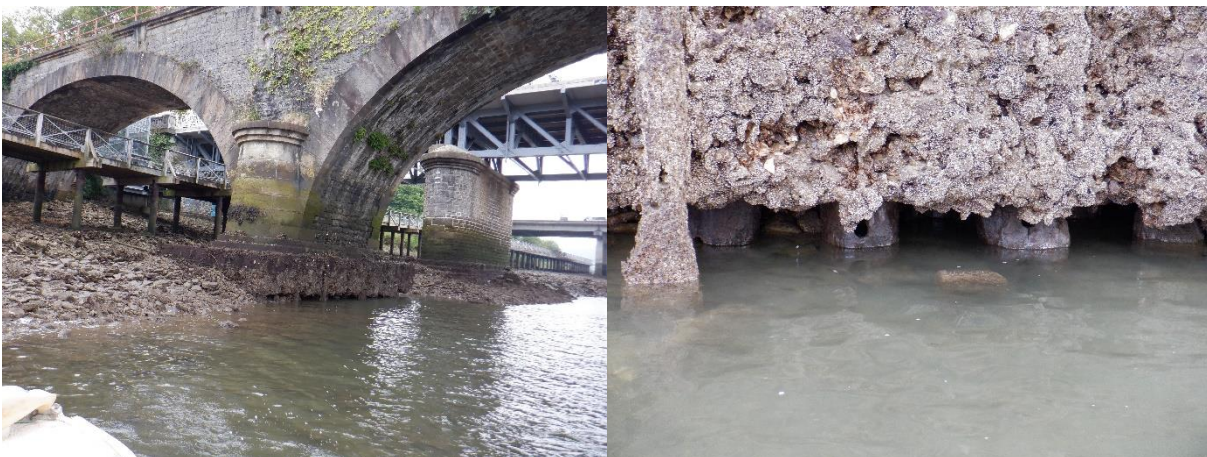
Figura 15. Pila 4 con pilotes de madera al aire
