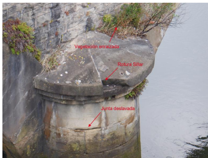
Figura 32. Afecciones pilares
