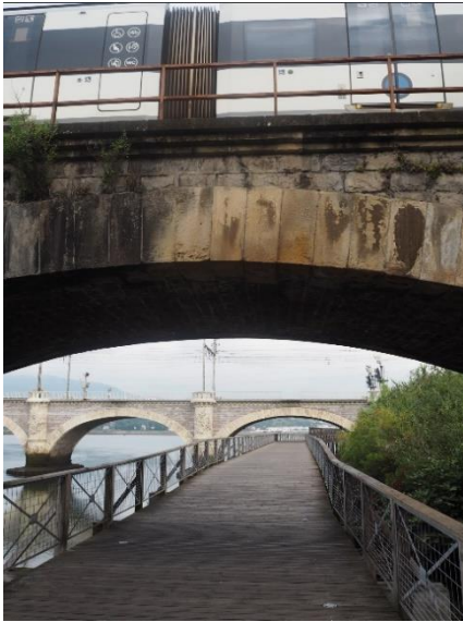
Figura 7. Vista aguas abajo desde pasarela
