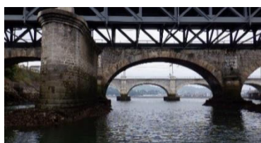
Figura 9. Vista aguas arriba desde embarcación
