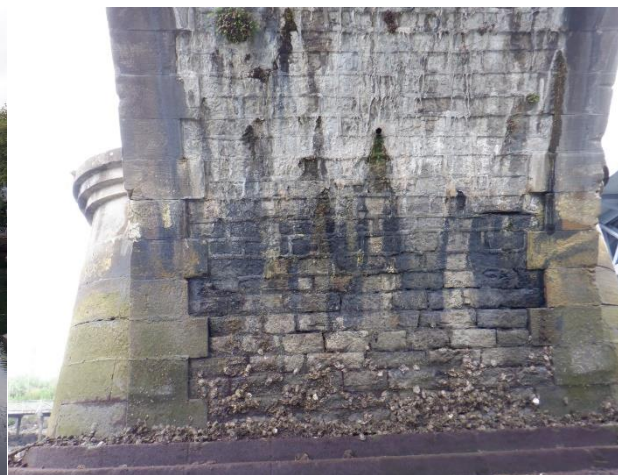
Figura 14. Vista transversal de bóveda
