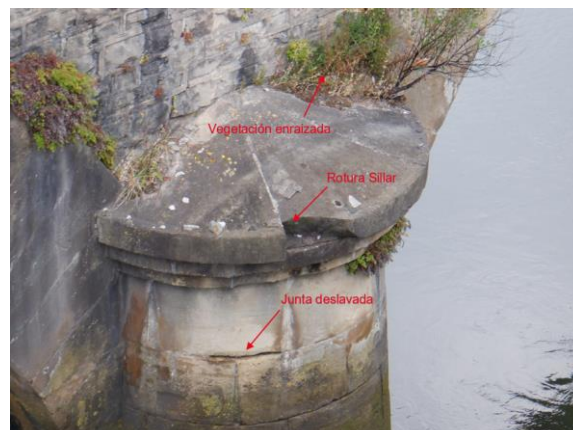
Figura 23. Afecciones pilares
