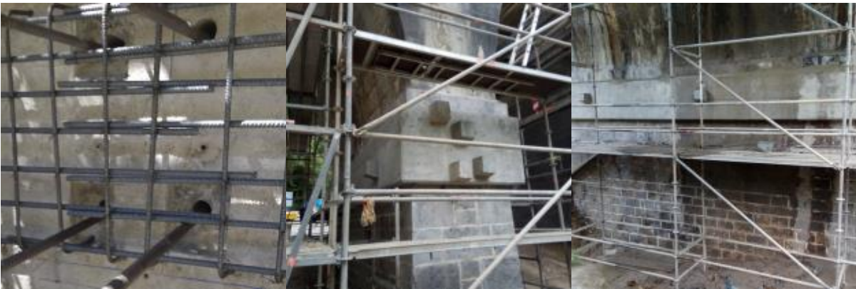
Figura 51. Zunchado mediante anclajes de cosido
