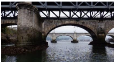
Figura 9. Vista aguas arriba desde embarcación
