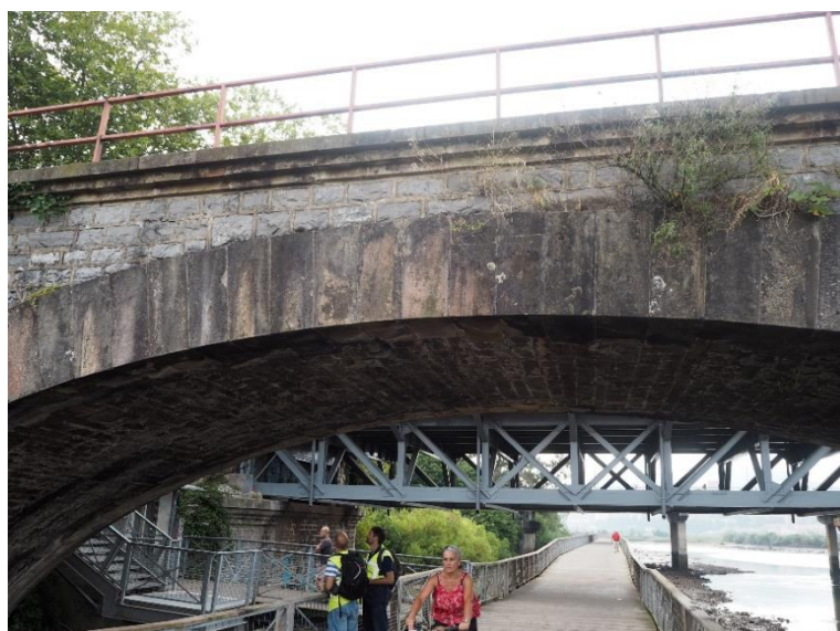
Figura 8. Vista aguas arriba desde pasarela
