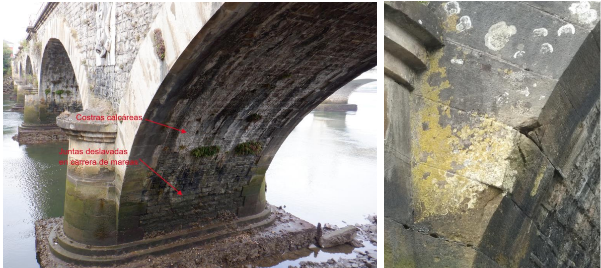
Figura 33. Afecciones bóvedas
