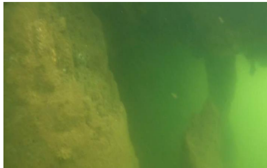
Figura 22. Pila 1. Cavity bajo encepado de pila 1
