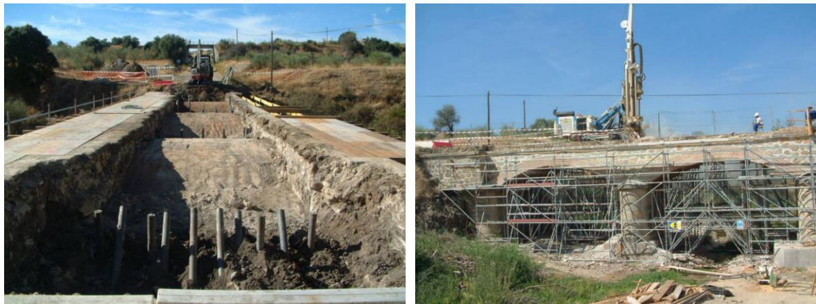
Figura 52. Refuerzo del Puente de Villamanta con micropilotes a través de la pila
