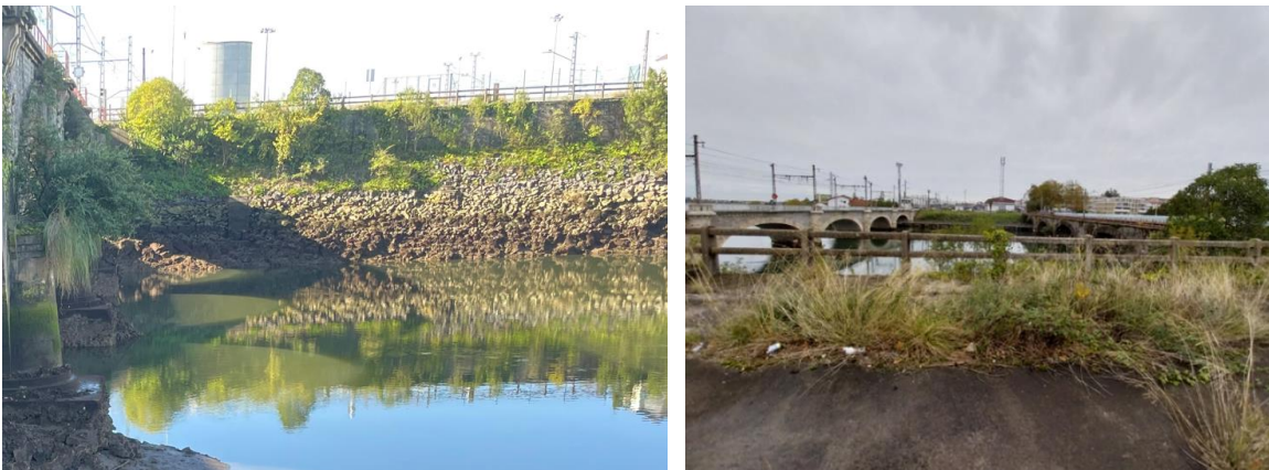
Figura 46. Zona de acceso entre puentes
