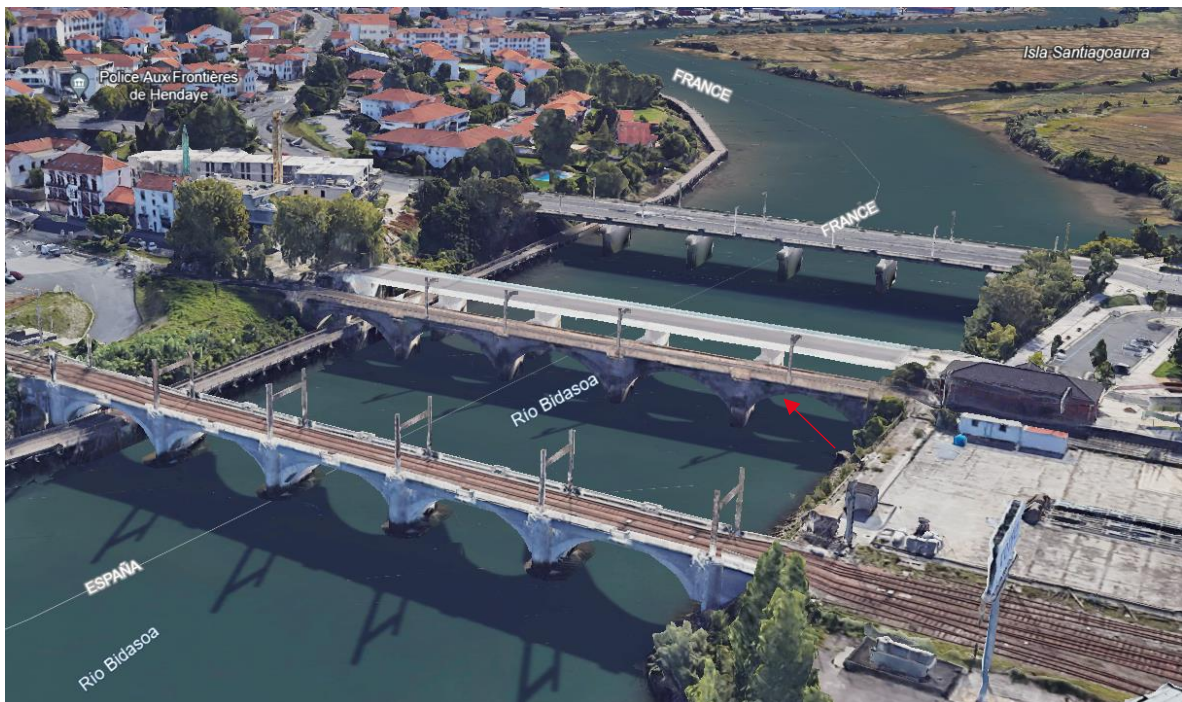
Situación del Puente Internacional de Irún (1912), señalado con la flecha roja.
