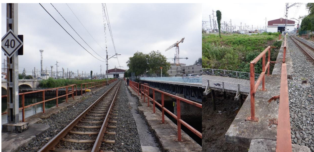
Figura 23. Vista superestructura y apartaderos en pila
