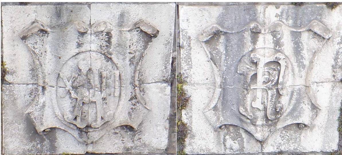
Figura 17. Escudos existentes en el puente
