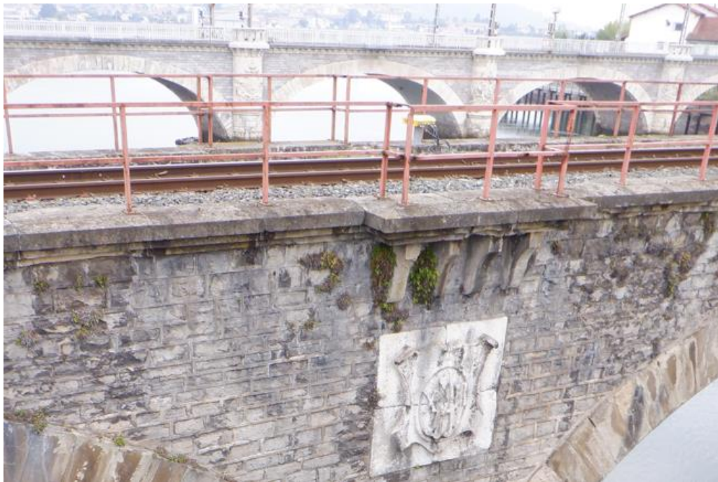
Figura 22. Viguetas descansillos en pilas
