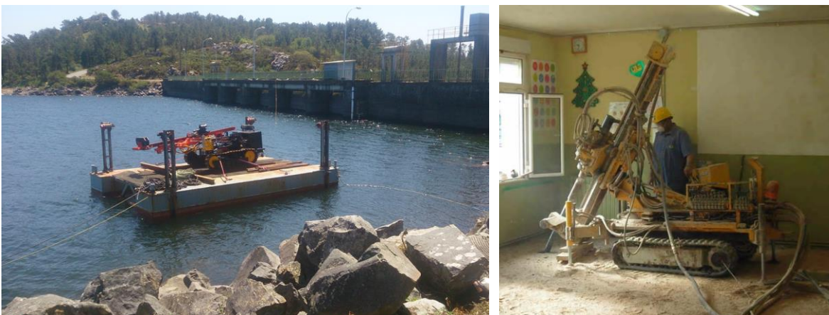
Figura 66. Pontona y micropilotadora de dimensiones reducidas
