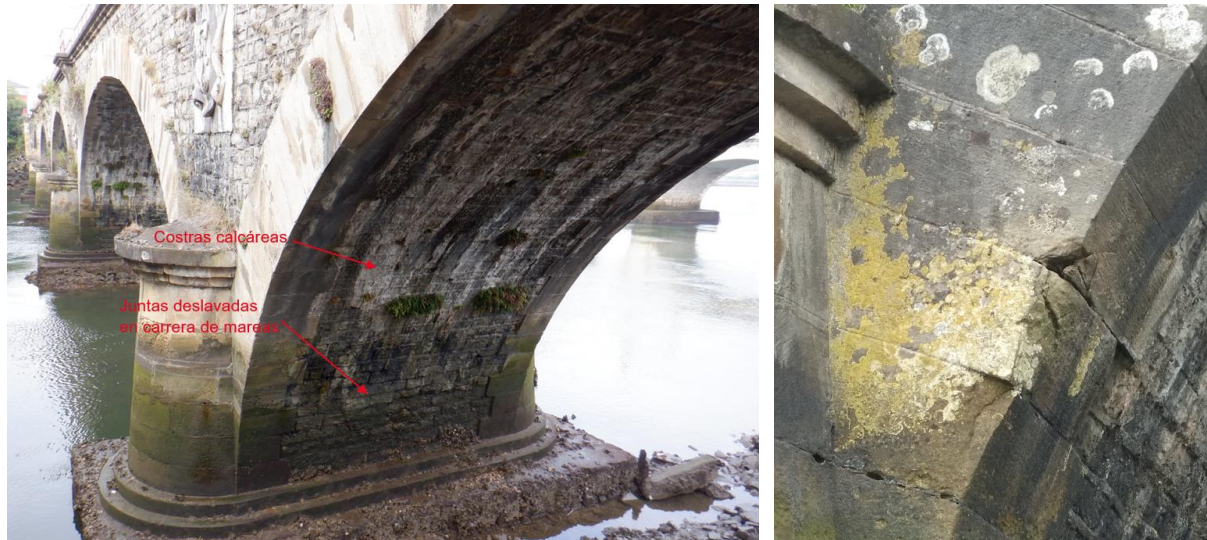
Figura 24. Afecciones bóvedas
