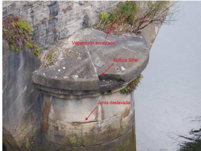
Figura 28. Afecciones pilares
