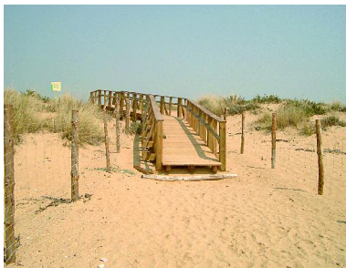
Foto 8.3.9. Detalle de pasarela sobre el cordón dunar.
