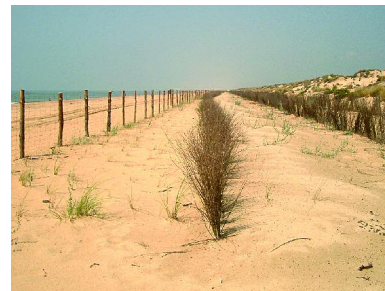
Foto 8.3.7. Incipiente captación de arena en primera fila.
