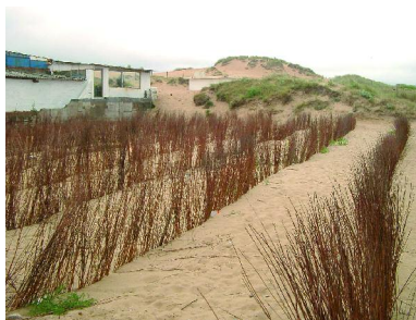
Foto 8.1.6. Filas de captadores para regenerar la duna.
