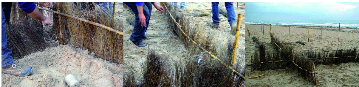
Foto 8.2.2. Proceso de montaje de los captadores de Spartina .
