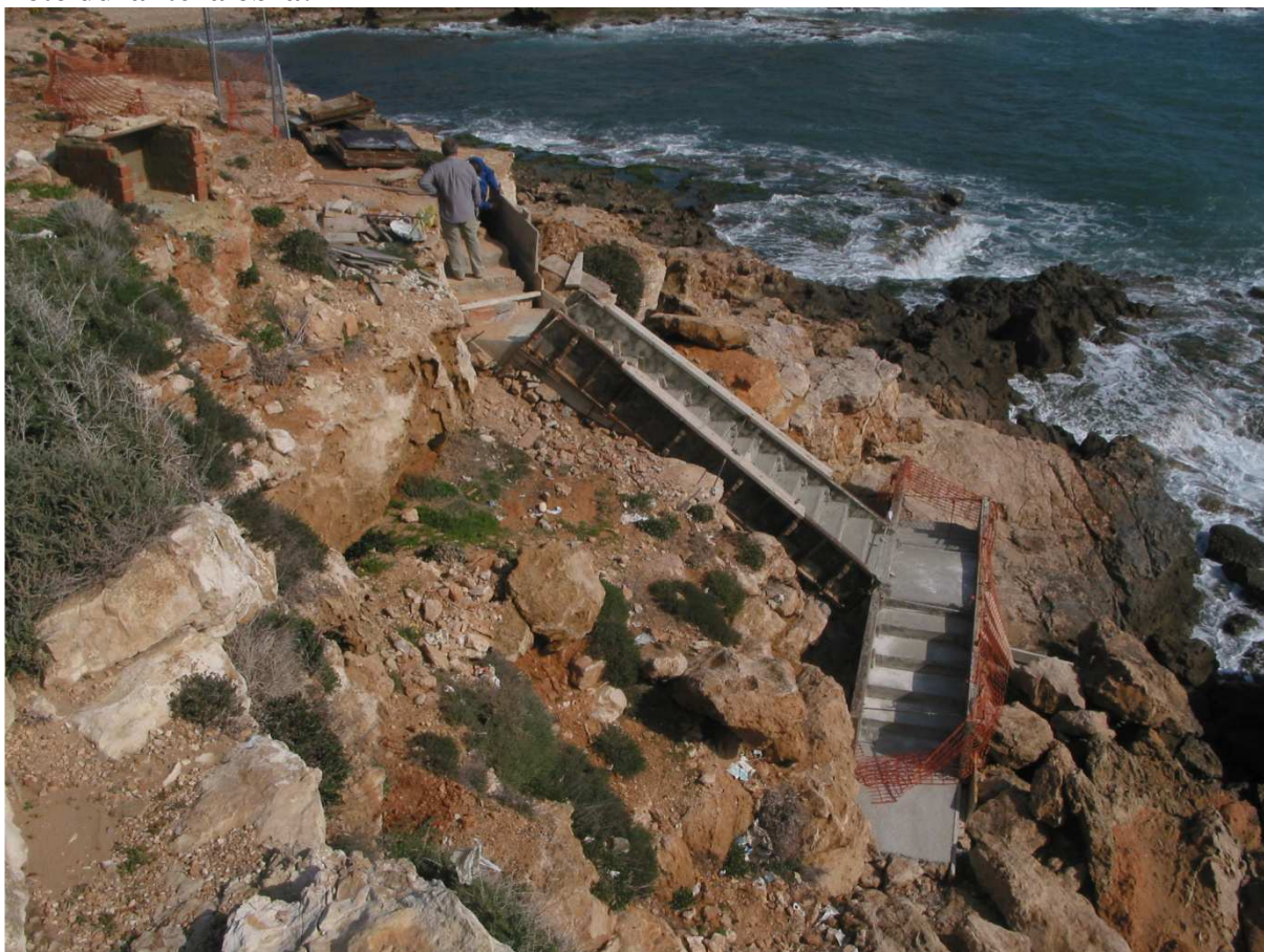
Foto durante la obra:
