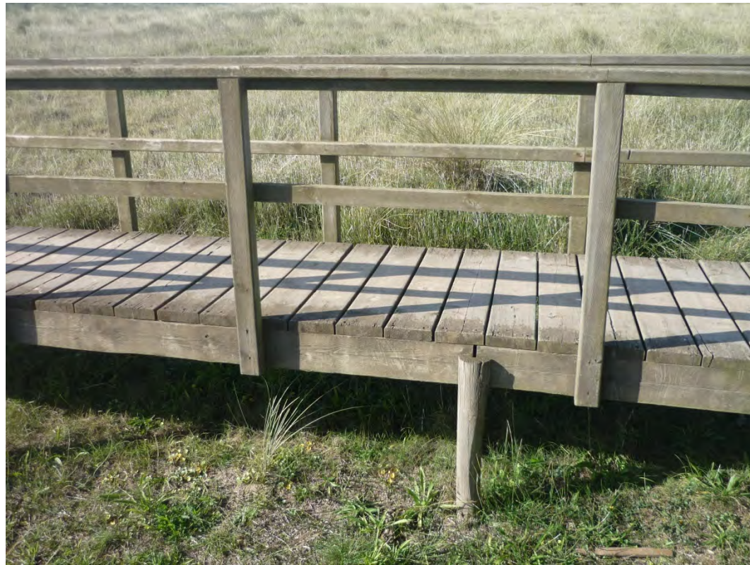
Figura 13 Detalle de la pasarela existente
