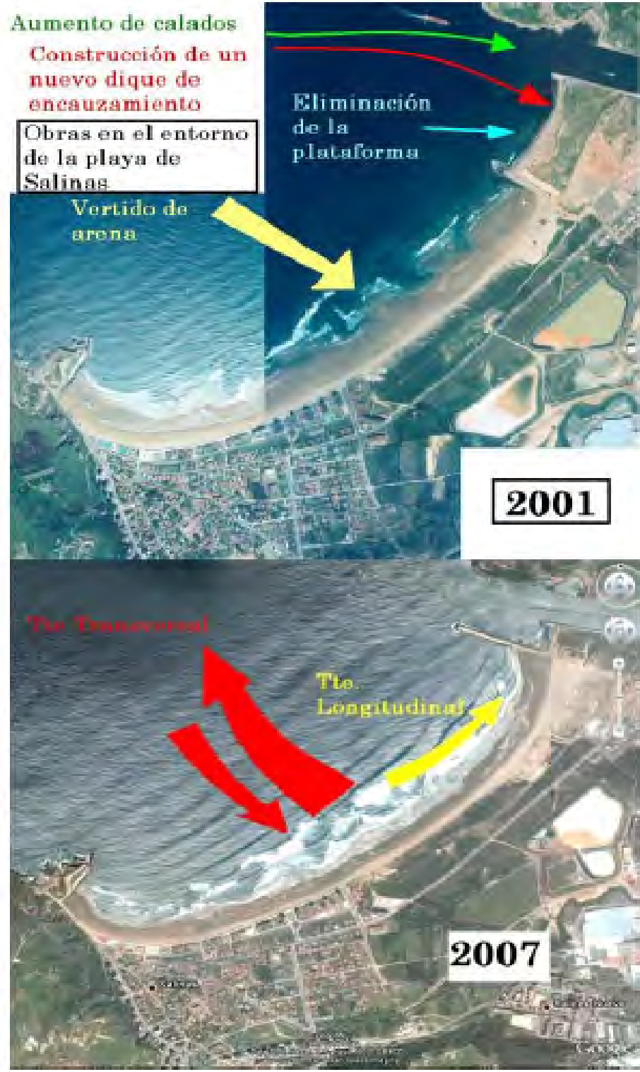
Figura 22 Obras del 2001 y transportes de arena sobre fotografía del 2007
