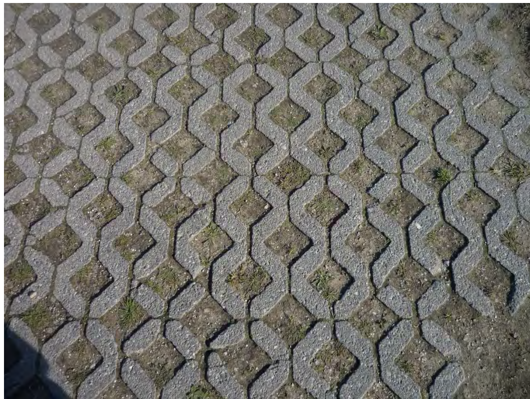
Figura 14 Detalle de la pavimentación del vial al norte del aparcamiento
