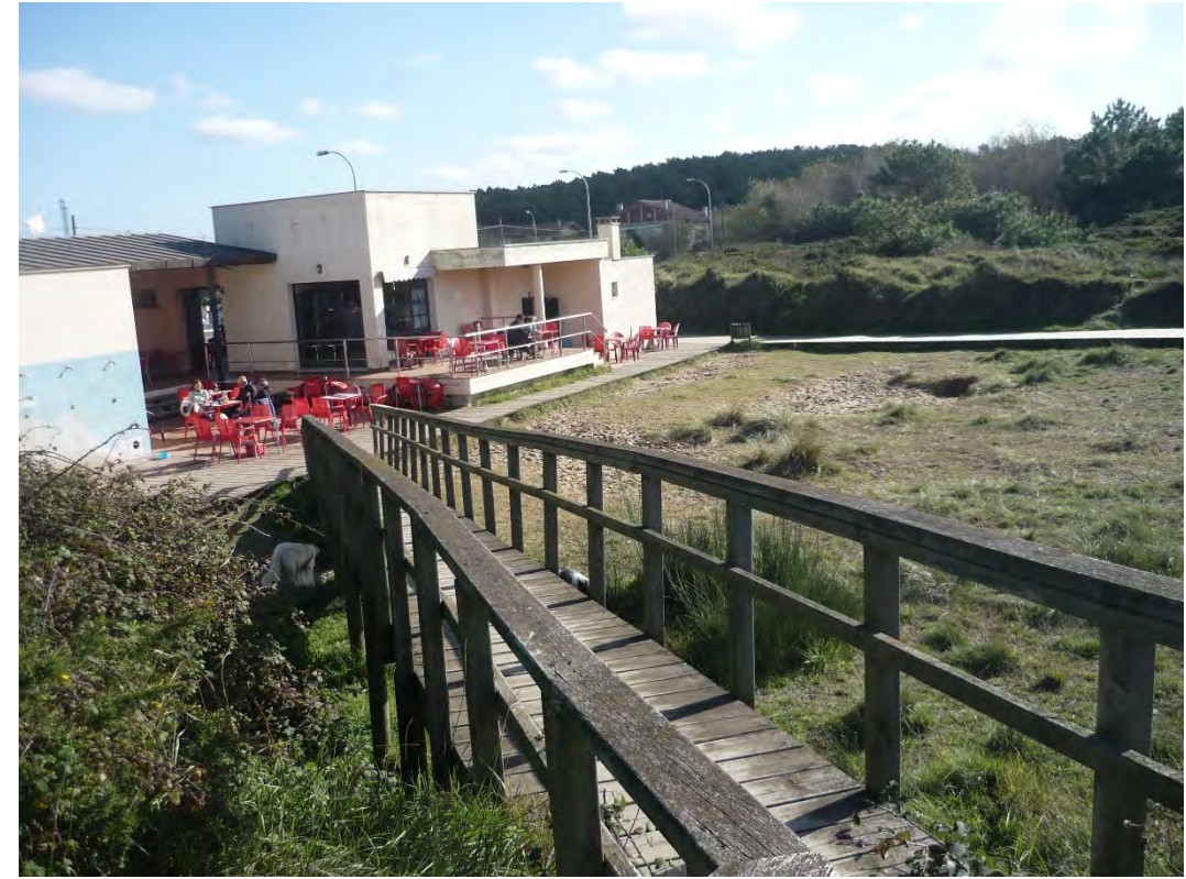
Figura 19 Edificio de servicios situado en la esquina noroccidental del aparcamiento
