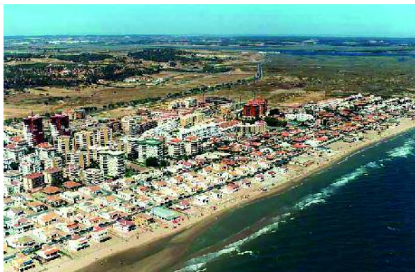
Foto 4.6. Destrucción de sistema dunar por la urbanización de La Antilla (Lepe, Huelva).
