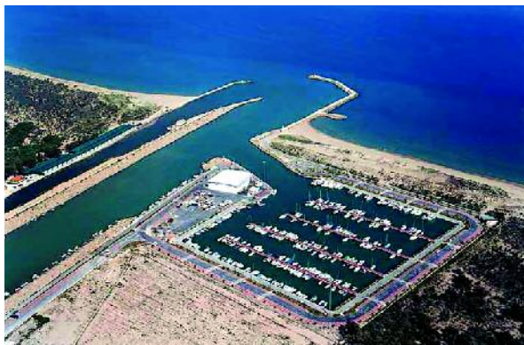
Foto 4.10. Construcción de diques y puertos en Guardamar (Alicante).
