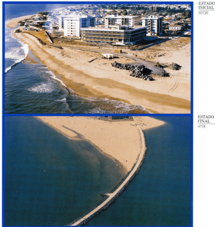
Figura 2.12: Dique de Punta Umbría (fuente: Actuaciones en la Costa, Dirección General de Puertos y Costas 1988)
