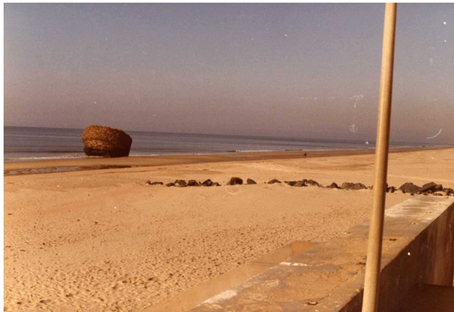
Figura 1.17: Playa de La Higuerita en Matalascañas en 1982, donde, como se aprecia en la foto, se tuvo que construir espigones de protección, ya entonces casi enterrados
