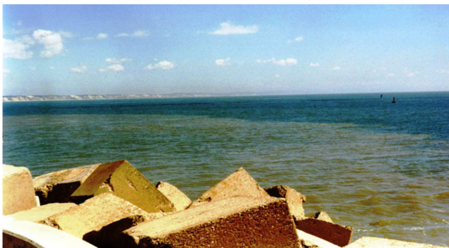
Figura 2.10: Paso de sedimentos frente al morro del dique Juan Carlos I del Puerto de Huelva
