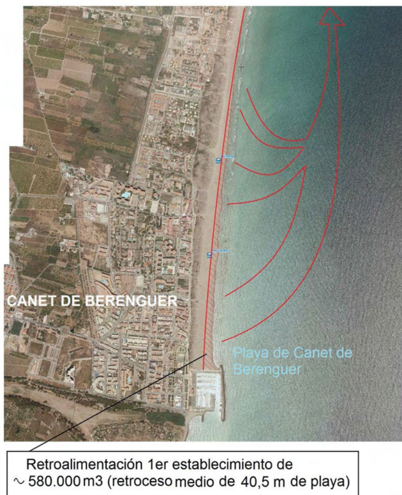
Figura 6.34: Actuaciones propuestas en el Tramo II entre la gola del Estany o del Queralt y el puerto de Canet de Berenguer (foto: DGSCyM)
