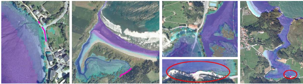
Figura 3.245. Detalle de las infraestructuras críticas afectadas en Ribadeo (panel izquierdo), Barayo (panel centro-izquierda), Ribadesella (panel en centro-derecha superior) y Niembro (panel en centro-derecha inferior y panel derecho) para E5: Inundación permanente por aumento del nivel medio del mar de 1 m a 2100.
