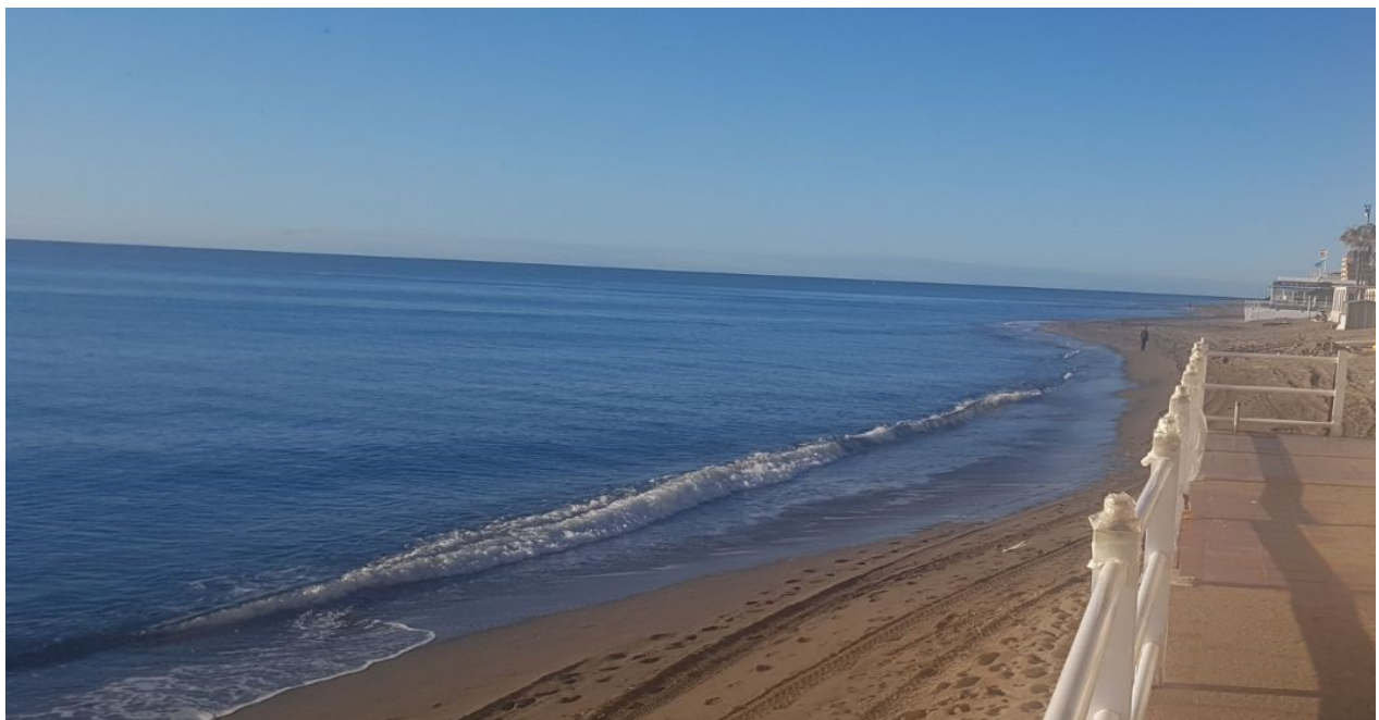
CHIRINGUITO BOTAVARA DESPUES DEL TEMPORAL
