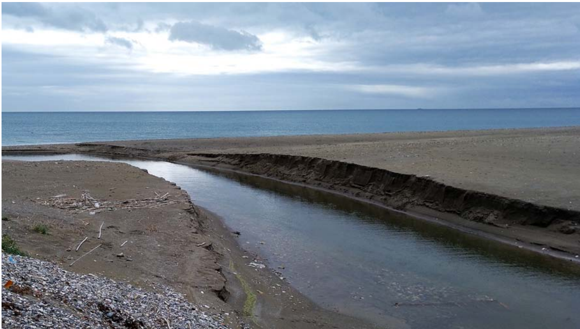
CASARES: EROSION PLUVIAL.
