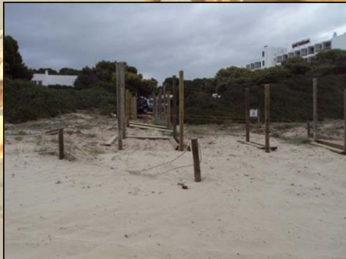
EJECUCIÓN DE LA ACTUACIÓN
