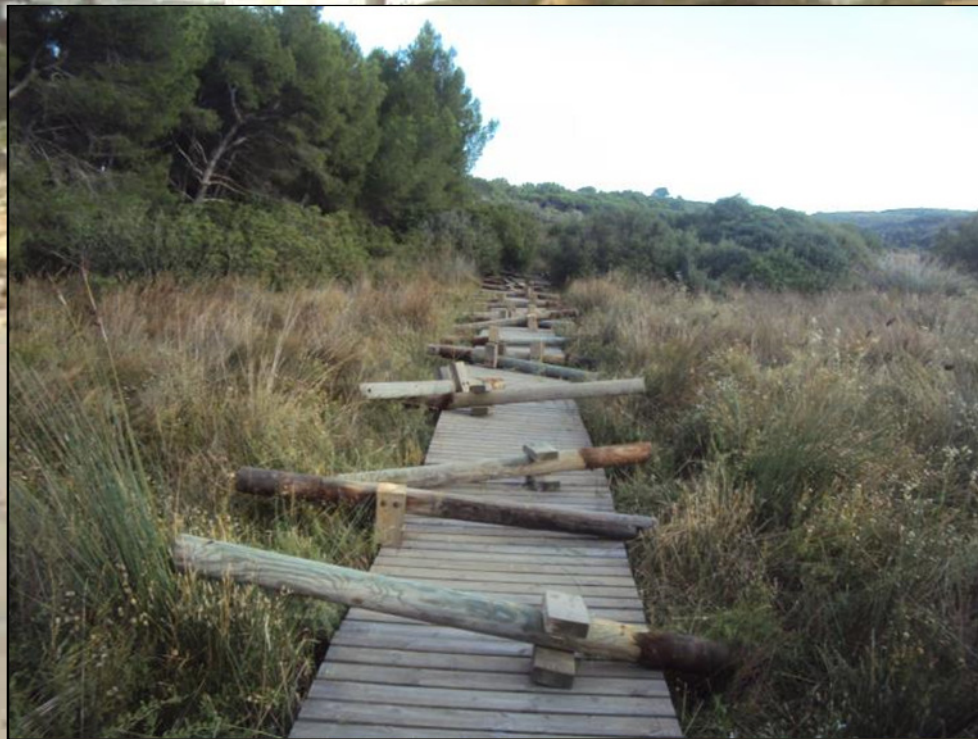
EJECUCIÓN DE LA ACTUACIÓN
