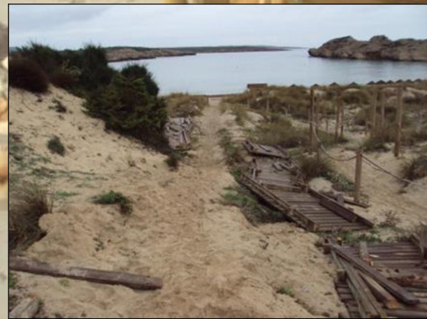
EJECUCIÓN DE LA ACTUACIÓN
