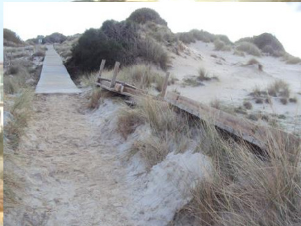
EJECUCIÓN DE LA ACTUACIÓN
