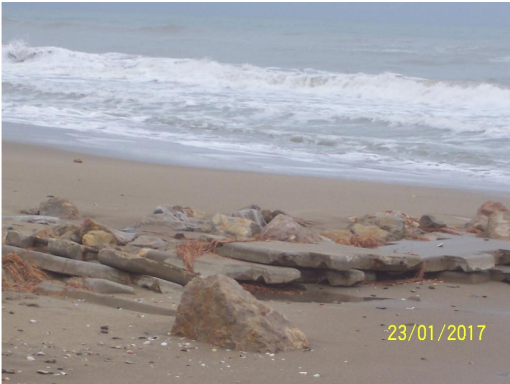
ESCOLLERA EN CALAFELL.
