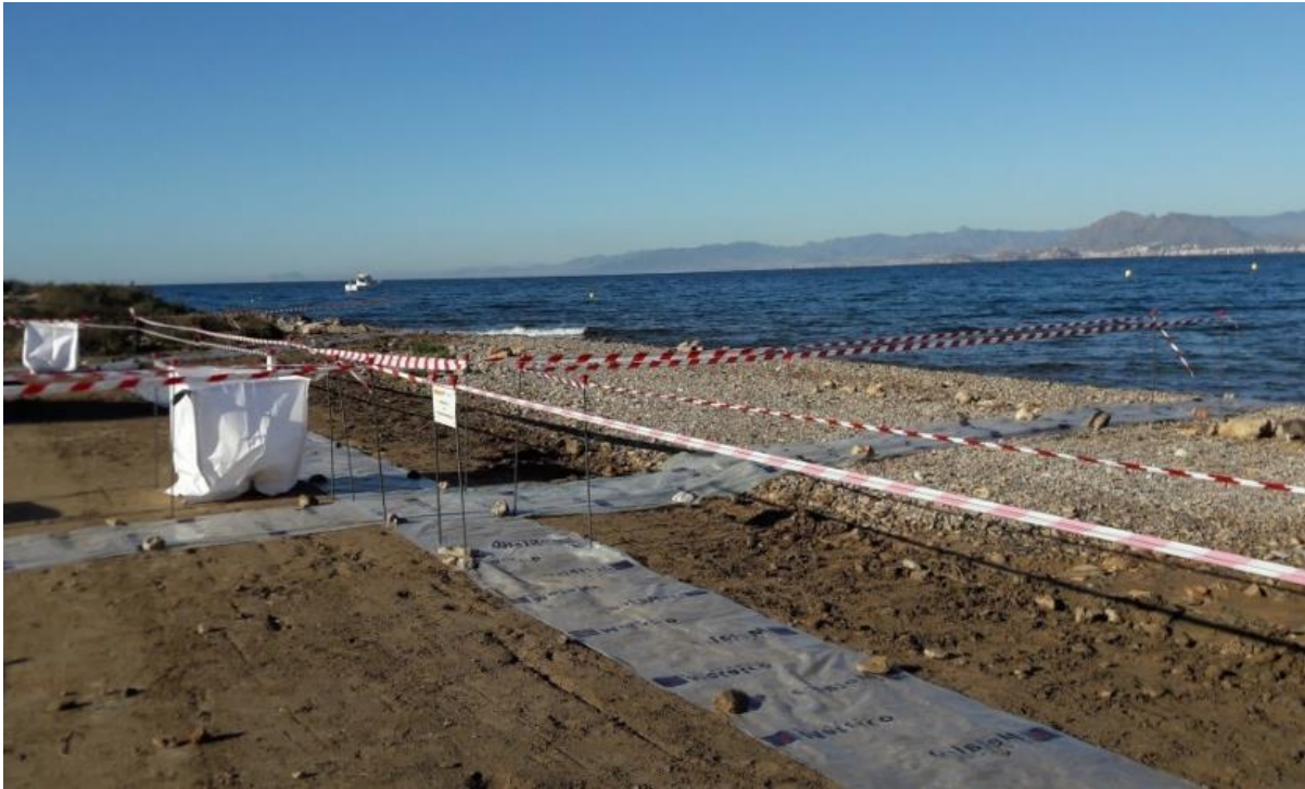
Ilustración 12. Zona de intervención señalada: corredor de descontaminación y depósitos de recogida intermedios
