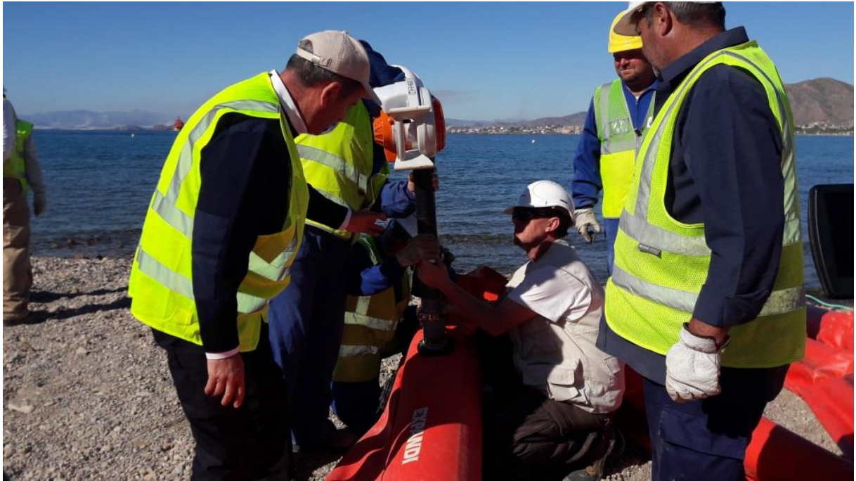
Ilustración 14. Llenado de aire de la cámara superior de la barrera selladora.
