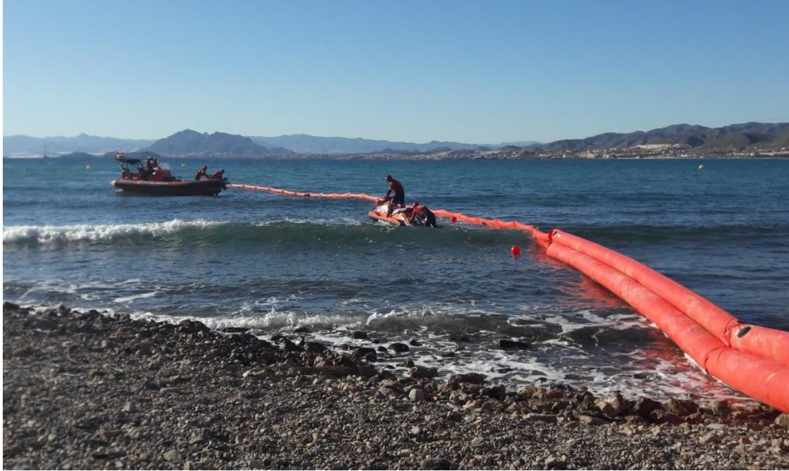
Ilustración 20. Fondeo de barrera de contención
