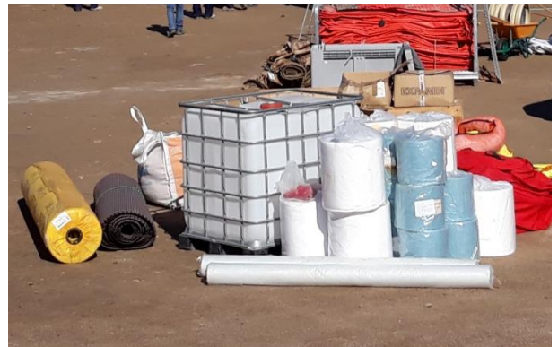
Ilustración 8. Materiales absorbentes, geotextil y GRG
