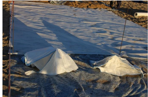
Ilustración 7. Material geotextil y sacas big-bag.
