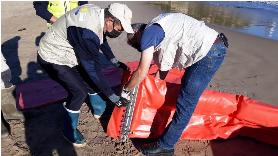
Ilustración 21. Empatado de barreras selladora y cilíndrica.
