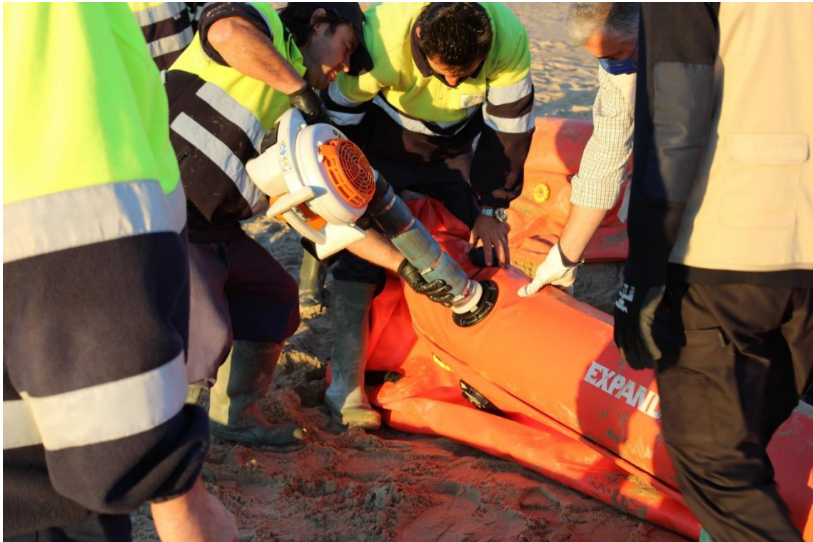
Ilustración 33. Inflado de la cámara de aire de la barrera selladora.
