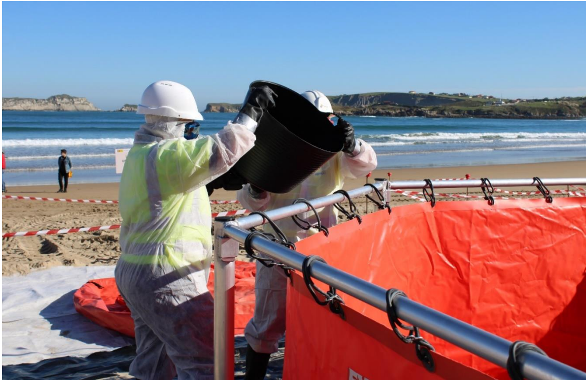
Ilustración 43. Personal de TRAGSA simulando el almacenaje del hidrocarburo recogido en un Fast Tank.
