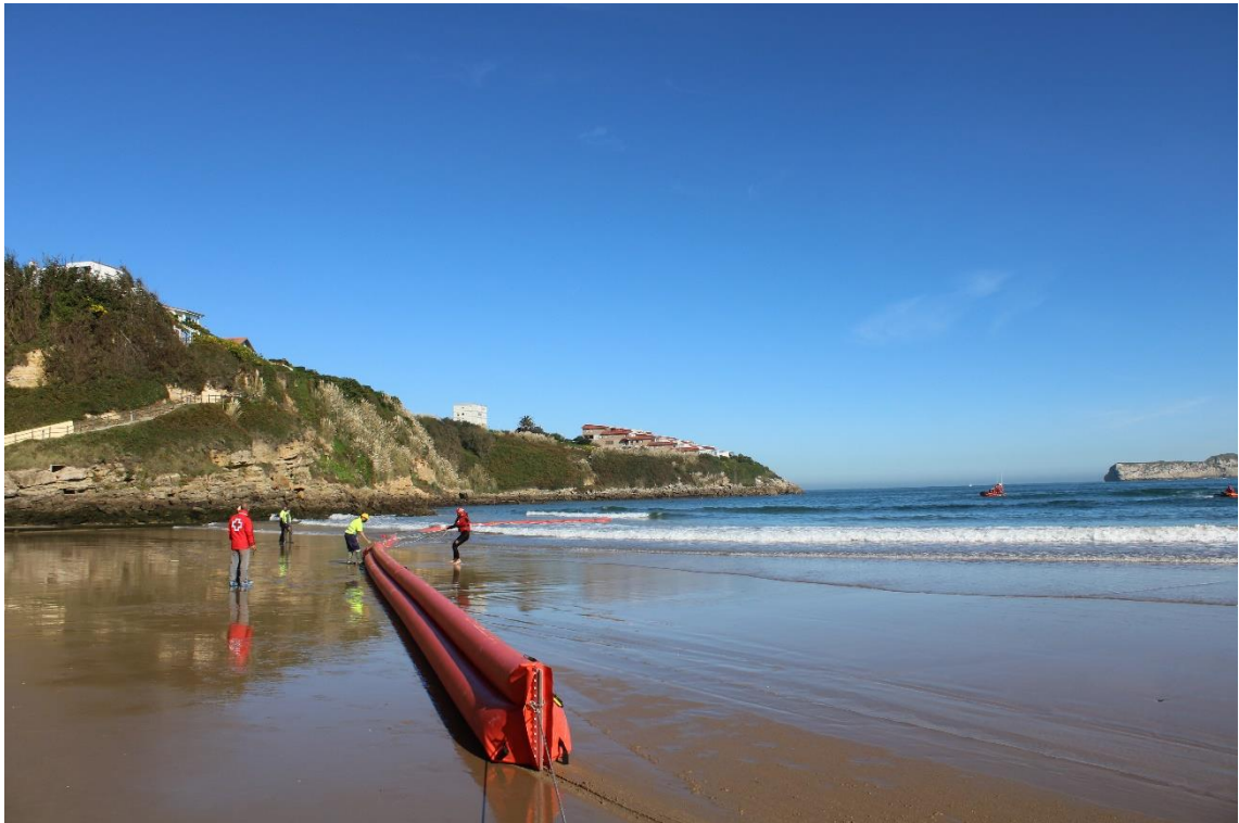
Ilustración 22. Maniobras llevadas a cabo debido al desplazamiento de la barrera durante el largado.
