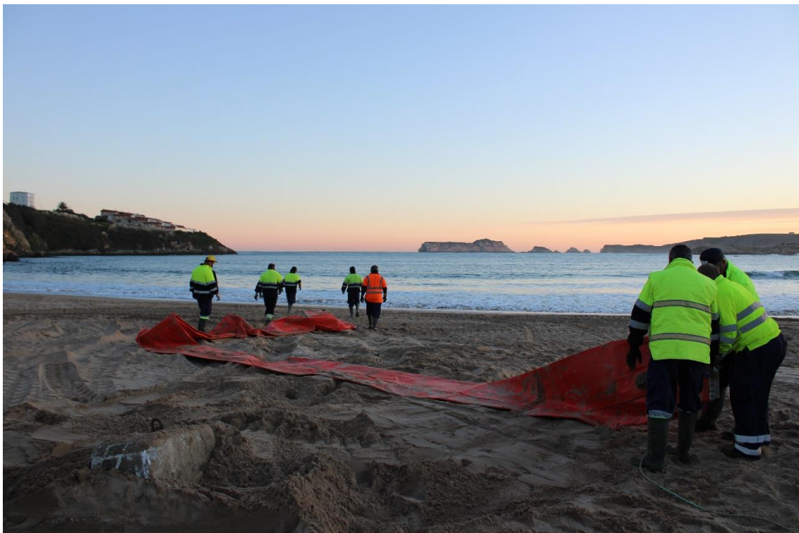
Ilustración 32. Momento del tendido de barrera selladora en la orilla.
