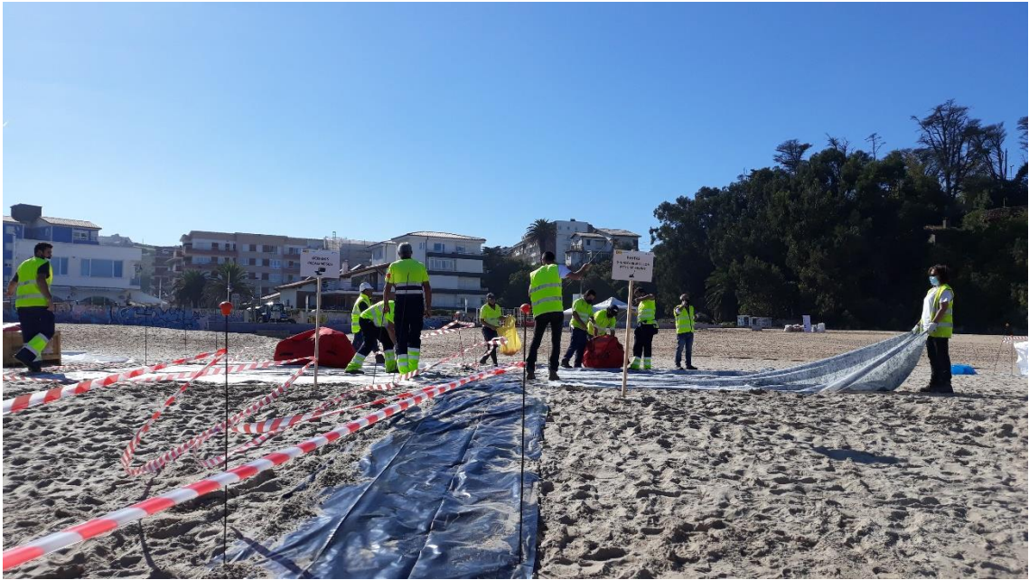
Ilustración 25. Personal interviniendo realizando el montaje de los tanques de almacenamiento.
