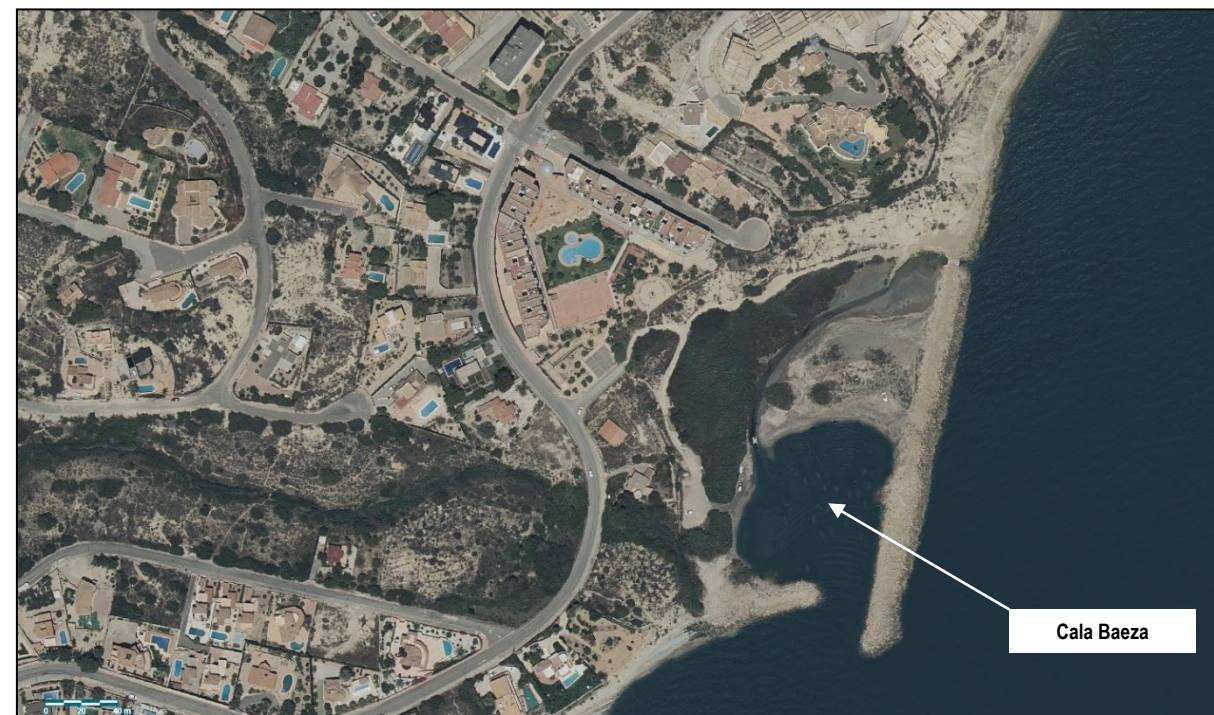
Estado actual de la zona de actuación (Cala Baeza).
