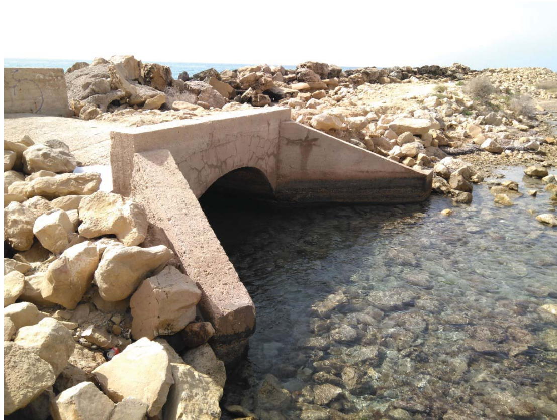
Obra de fábrica existente
